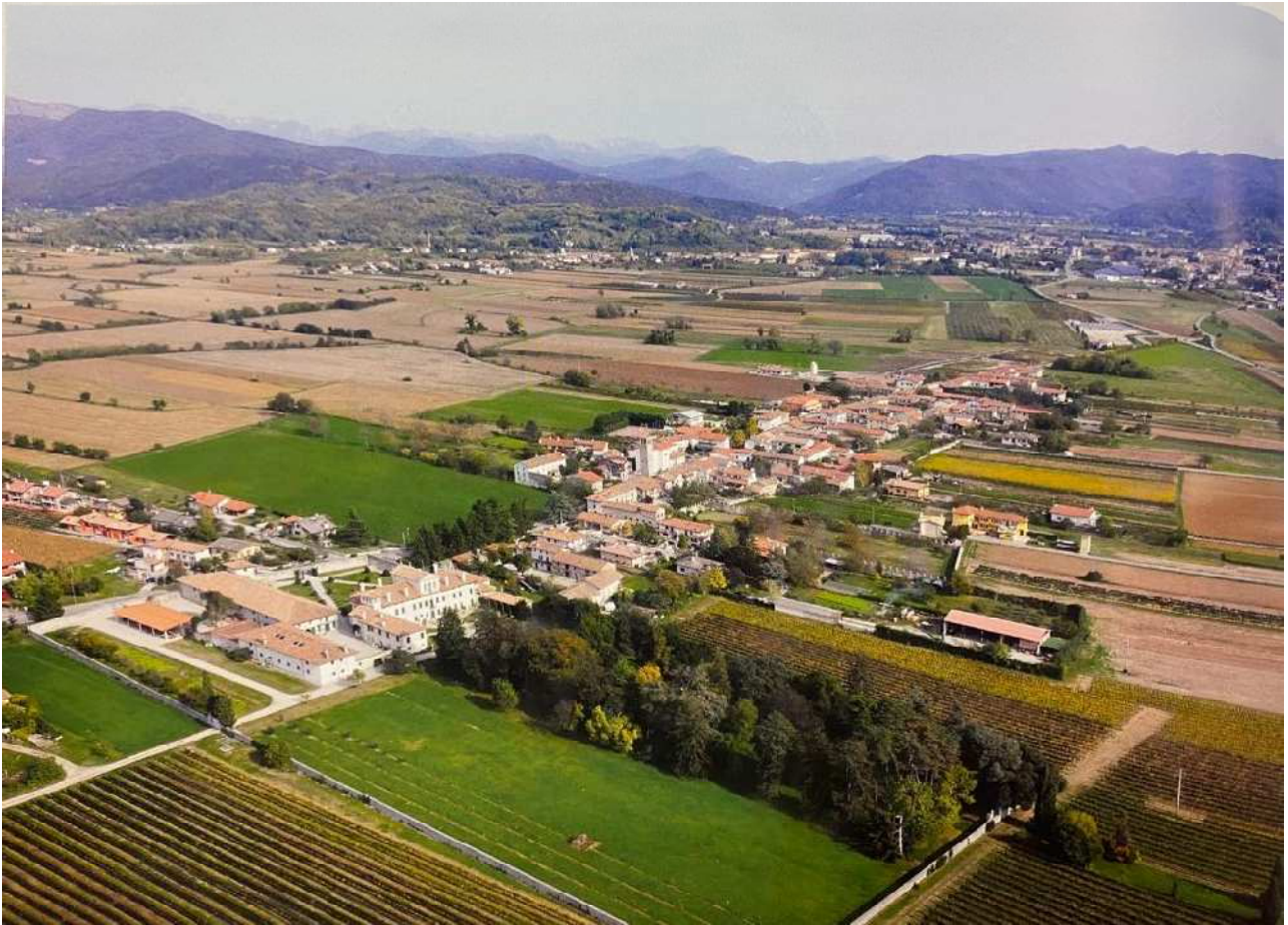
Figura) Botenico di Moimacco e la Villa nel paesaggio agricolo e suburbano. Sullo sfondo la città di Cividale del Friuli.
