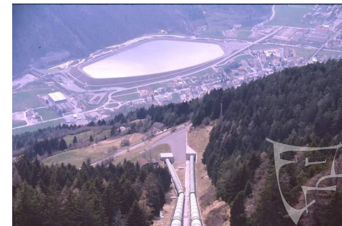
Impianto a pompaggio
