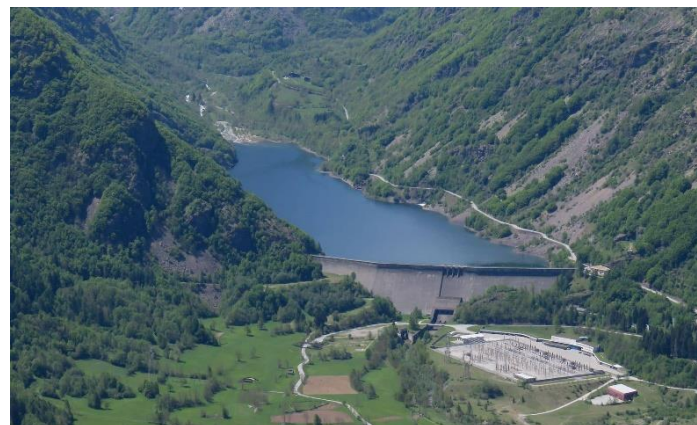
Impianto a bacino
