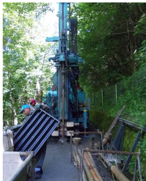
Figura 14: lavori di realizzazione del foro lungo la strada comunale
