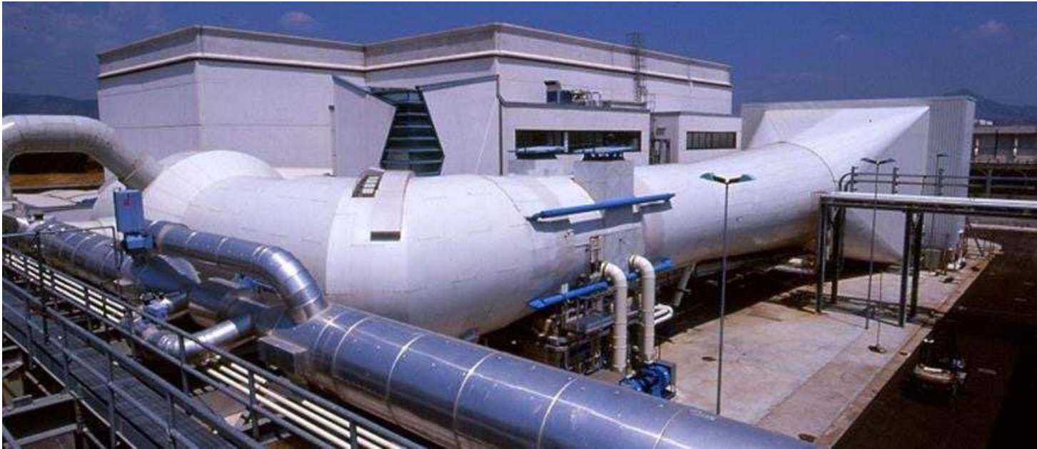
Fig 29: IWT (icing wing tunnel) una delle più grandi gallerie del vento per prove in ghiaccio esistente al mondo [29].
