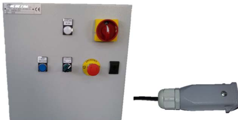
Figura 3.37 Quadro elettrico e presa per azionare il relè in remoto
