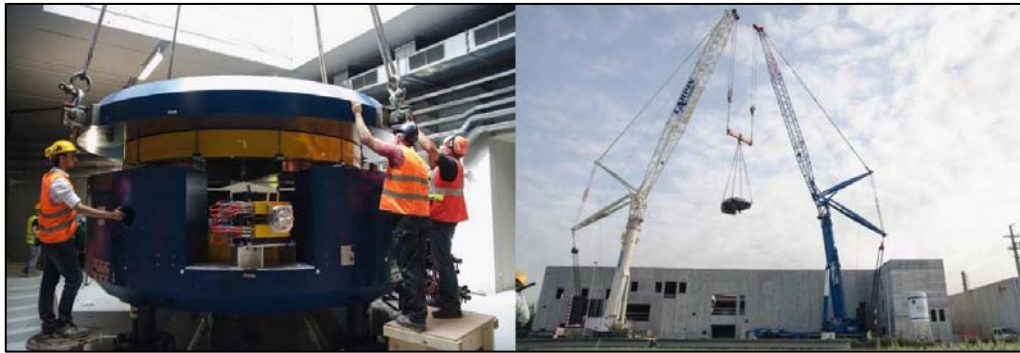
Figura 3.6 Fasi dell'installazione del ciclotrone BEST 70p nell'edificio SPES a maggio 2015.
