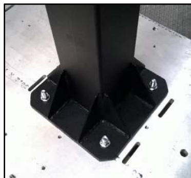
Figura 4.7 Nodo di incastro.
