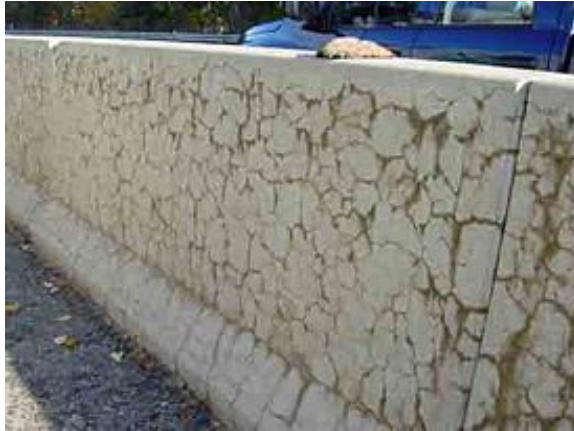
Fig. 1.1: Panorama fessurativo reazione ASR
