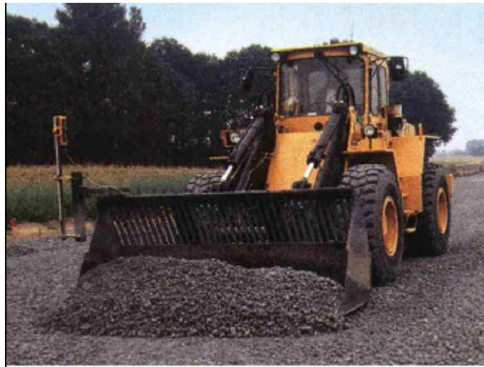
Fig. 1.3: EAF Slag usata per costruzione sottofondo stradale
