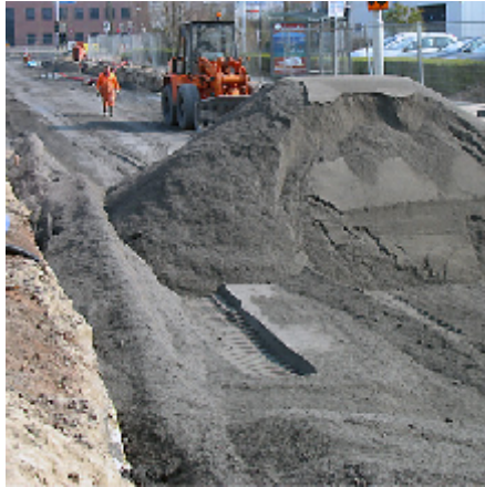
Fig. 2.14: B.A. usate per costruzione di strade.
