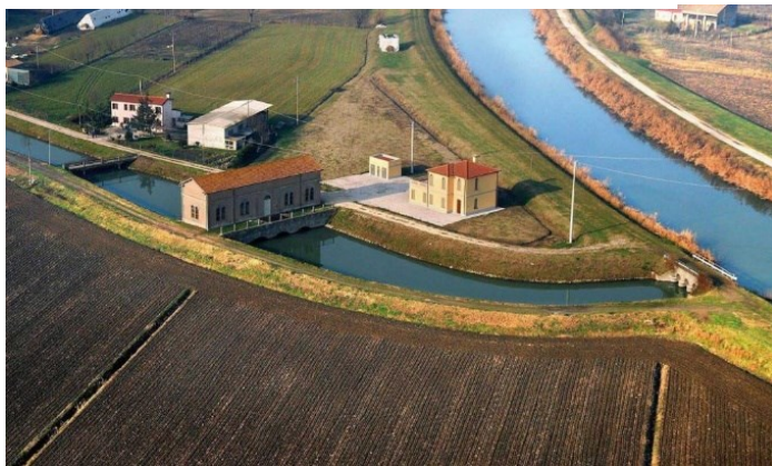
Figura 2 impianto idrovoro Polesine
