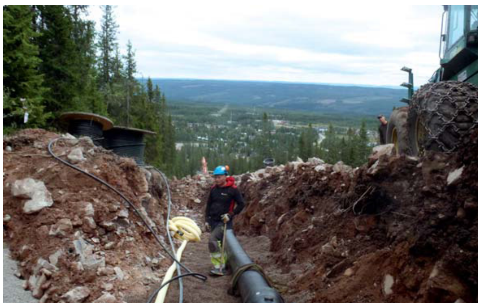
Figura 1.16 - Posa impianto d'innevamento artificiale nel comprensorio sciistico di Lagorai Novembre 2010
