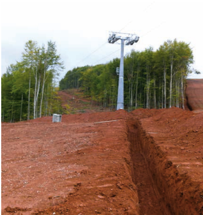
Figura 1.15 - Posa impianto d'innevamento artificiale nel comprensorio sciistico di Lagorai Novembre 2010
