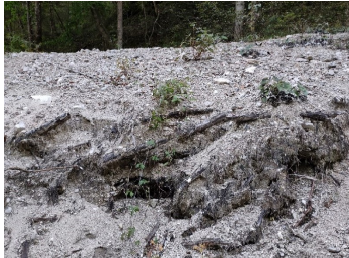
Foto 25: Sponda laterale con all'interno ceppaie e elementi vegetali, a seguito di accumulamenti laterali del detrito presente in alveo a seguito delle lavorazioni di sistemazione.
