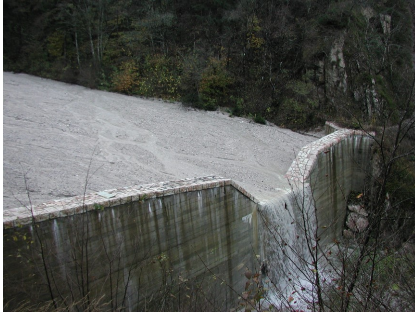
Foto 9: Briglia a finestre n°13 e piazza di deposito dopo l'evento del novembre 2004 (fonte: PISIF, T. Centa).
