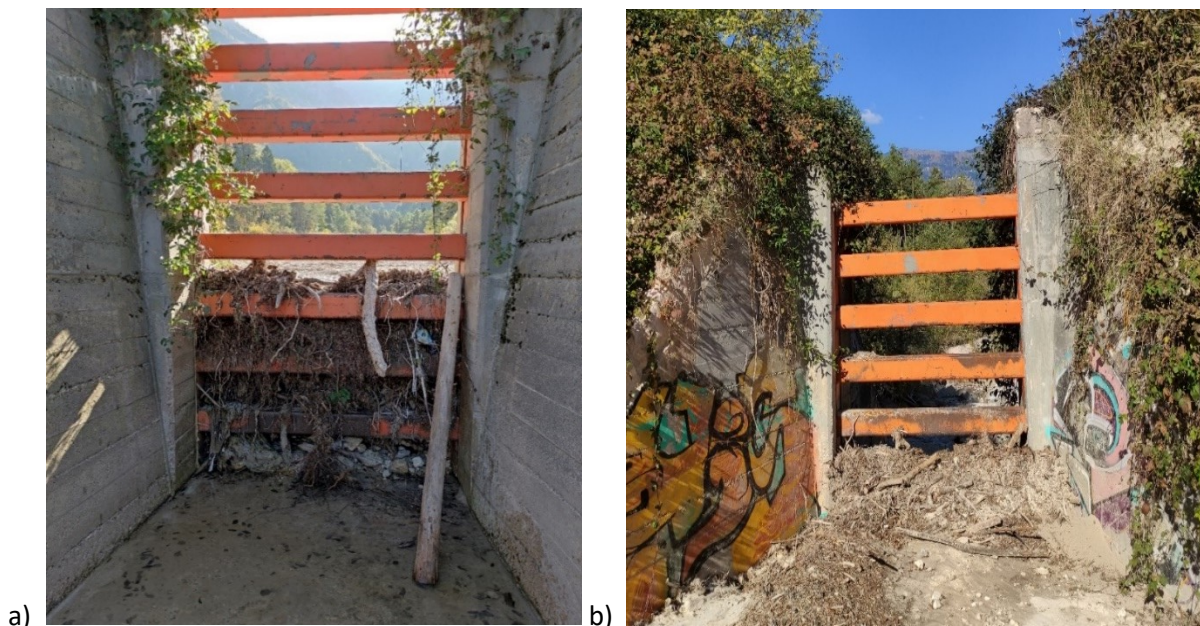
Foto 18: a) Briglia filtrante vista da valle con in evidenza due tronchi di media lunghezza;
