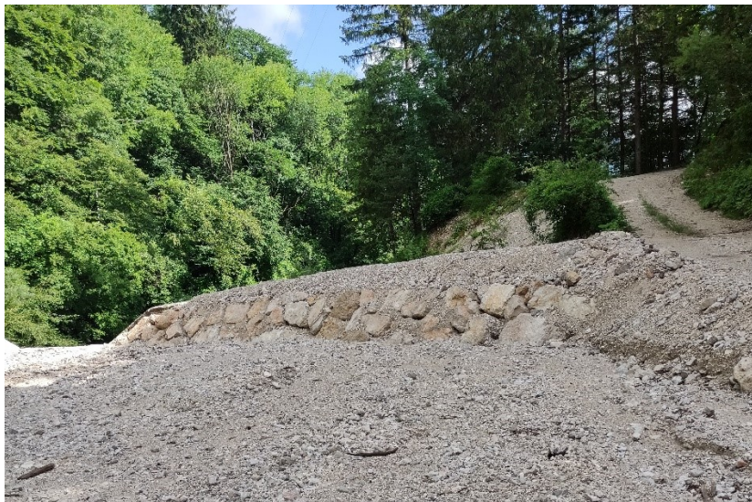
Foto 7: Scogliera in massi ciclopici a protezione dell'ala in destra idrografica della briglia n°13.
