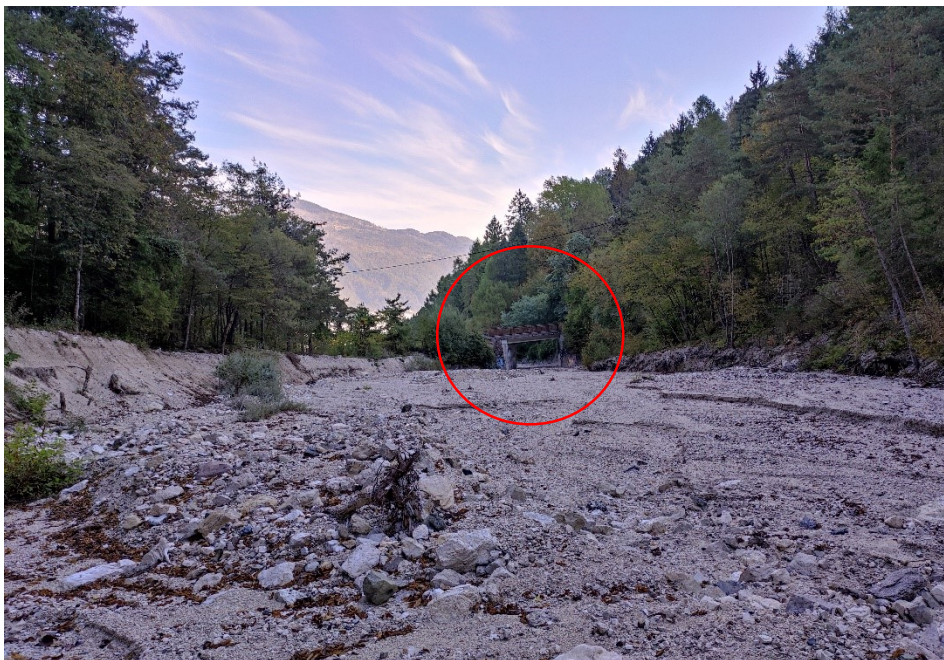
Foto 17: Piazza di deposito a monte dell’attraversamento della strada provinciale (cerchio rosso).
