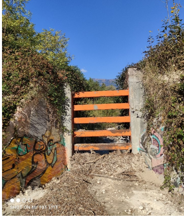
Foto 1: Briglia filtrante n°6 posta a protezione della zona a valle.
