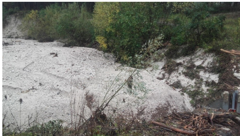
Foto 13: Legname di grosse dimensioni e detrito accumulato nei pressi della briglia filtrante (fonte: Servizio Bacini Montani TN).
