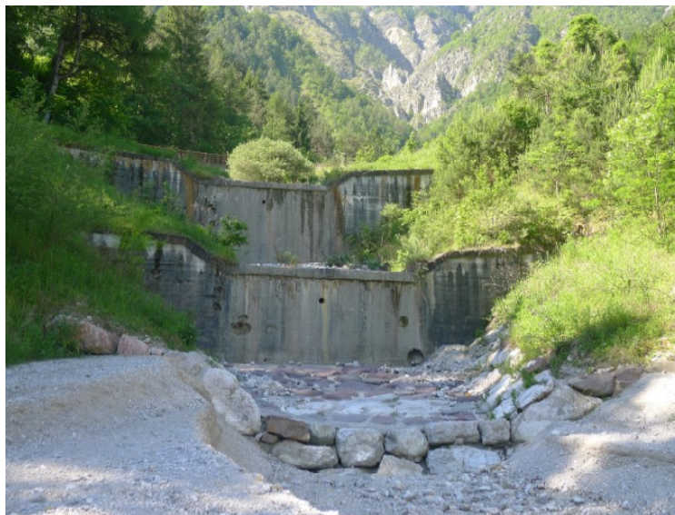
Foto 4: Briglie n° 7,8,9 in cemento armato poste a valle della strada provinciale.
