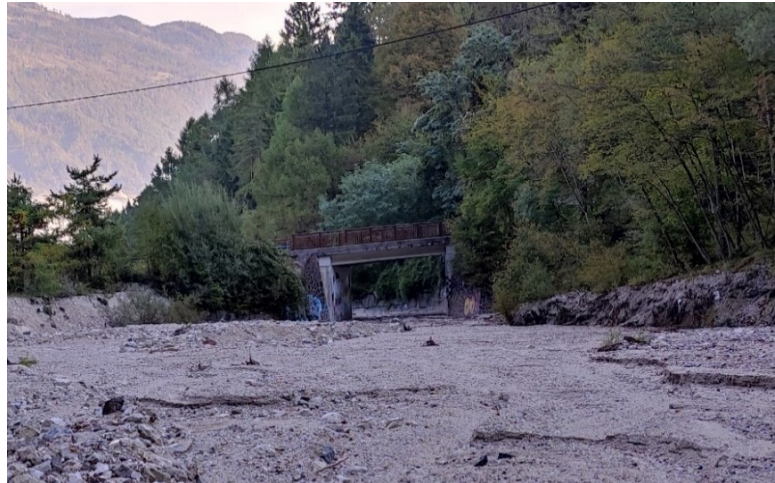
Foto 26: Ponte della Strada Provinciale SP133 e piazza di deposito a monte.
