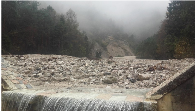
Foto 12: Materiale di grosse dimensioni a monte della briglia a finestre n.13, nella relativa piazza di deposito (fonte: Servizio Bacini Montani TN).
