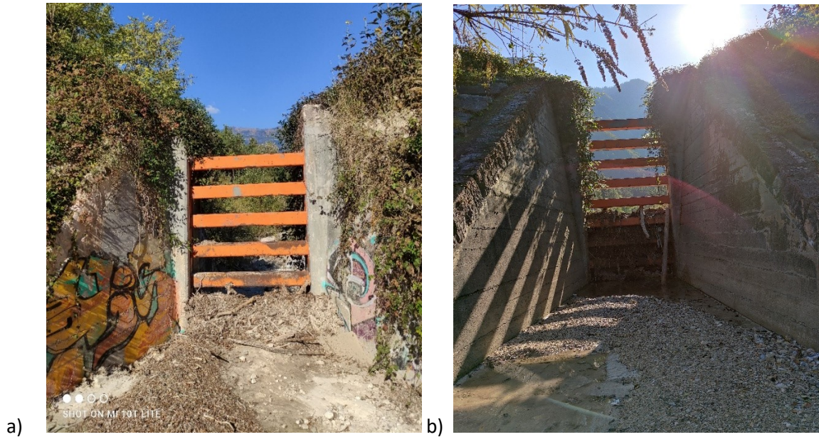
Foto 3: Briglia filtrante posta a chiusura del bacino del rio Rì: a) vista da monte; b) vista da valle .
