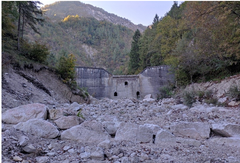
Foto 5: Briglia a finestre n.13 e soglie in massi ciclopici a valle della stessa.
