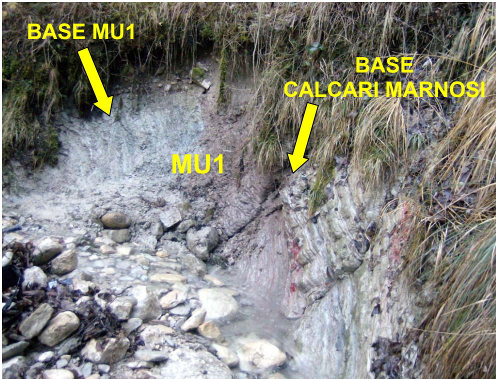
Fig. 6.4- Marly Unit 1 (MU1) dell'Eocene inferiore sovrastata da calcari marnosi e marne prevalentemente verdastri.
