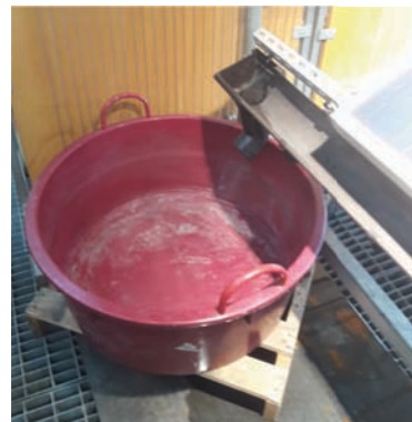
Figura 19 – Grondaia e bacinella per raccolta acqua.
