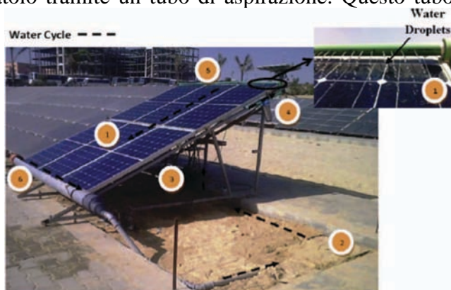
Figura 5 - Sistema fotovoltaico ibrido FV/T raffreddato ad acqua.
