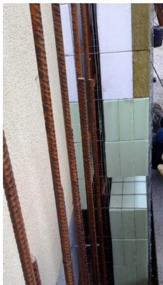
Figura 16 Cassero con zoccolatura in XPS, sponda interna in EPS, isolante esterno in EPS con grafite
