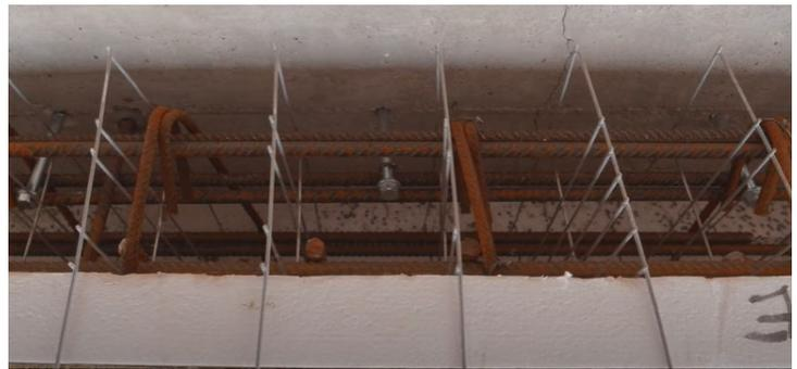
Per quanto riguarda invece i connettori posti verticalmente in corrispondenza di eventuali pilastri si consiglia di eseguire il foro preliminarmente al posizionamento del cassero e di inserirli una volta che il cassero è in posizione: ciò è possibile spostando temporaneamente la striscia di isolante esterna.
