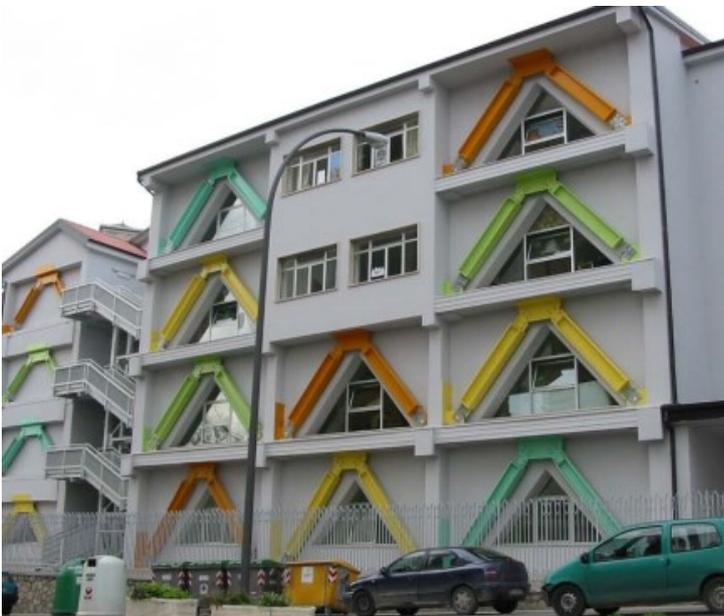
*Figura 5 Plesso scolastico "G. De Petra" Casoli (CH) Controventi metallici a "V rovescio" dotati di dispositivi silicnici fluido-viscosi pressurizzati*
