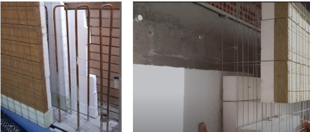
La presenza di vuoti dietro ai moduli non è conforme ad una posa a regola d'arte perché può comportare:
