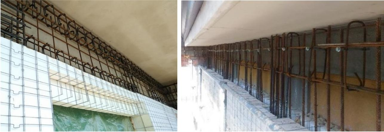
A betoncino ancora fresco si poserà esternamente un pannello isolante di completamento fornito dal produttore che andrà a solidarizzarsi al betoncino una volta indurito, assicurandosi di non lasciare vuoti. Il pannello verrà tenuto in posizione con apprestamenti temporanei fino all'indurimento del getto, andando poi ad applicare una tassellatura per assicurare il fissaggio.
