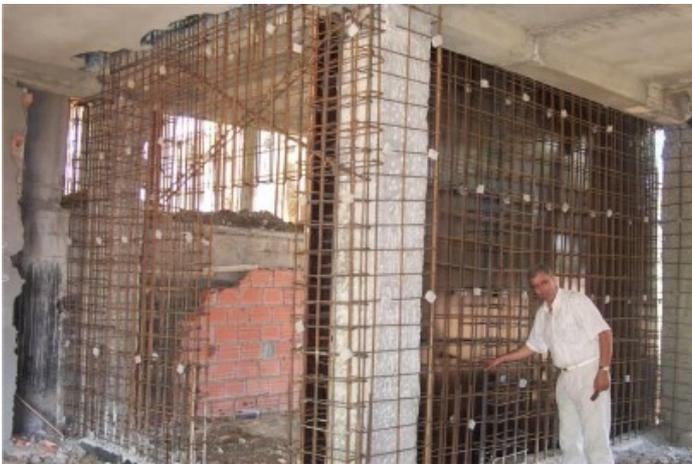
*Figura 7 Intervento con aggiunta di nuove pareti strutturali prima dopo la finitura esterna*
