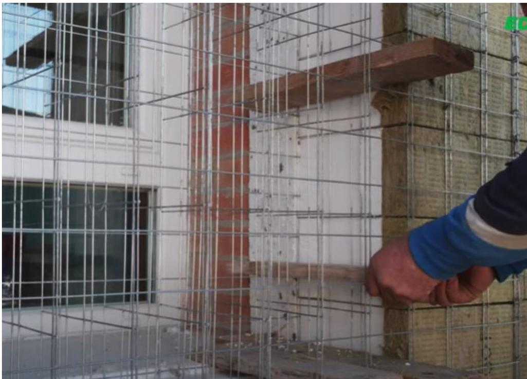
Figura 66 Schemi di sostegno delle chiusure laterali con soli morali di legno 5x5 cm
