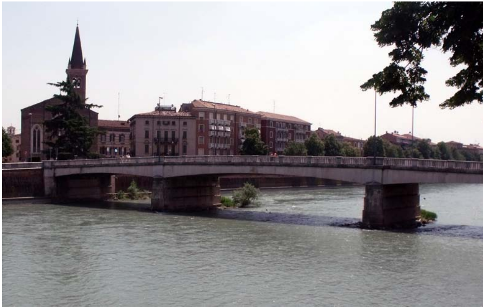
Figure 6.1: Ponte Nuovo del Popolo, Verona.
