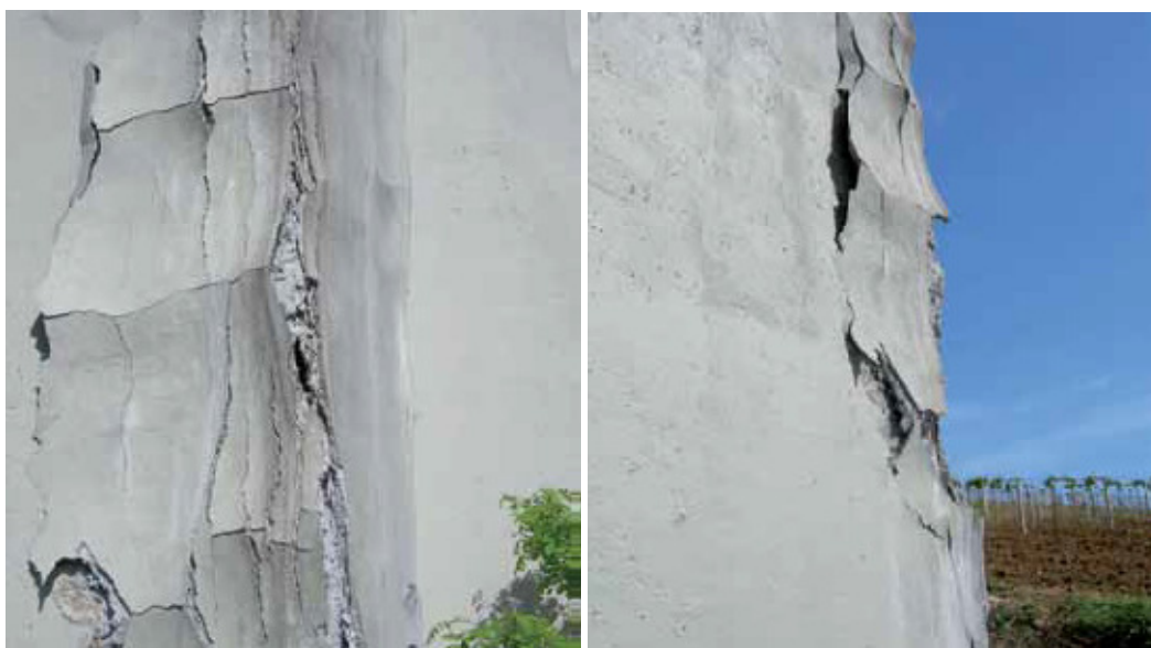
Figura 1.4 - Esempio di aggressione solfatica.
