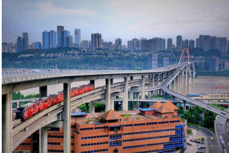
Figura 5.2 Caiyuanba Yangtze River Bridge (ponte stradale e ferroviario) (L'immagine proviene da internet)
