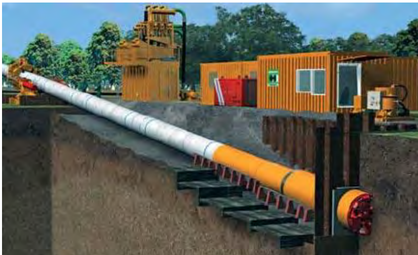
Fig. 9: Pozzo di partenza.
