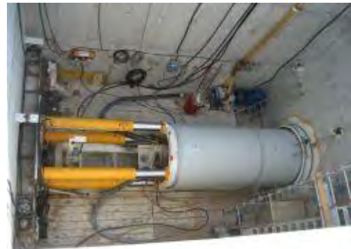
Fig. 7: Pozzo di spinta
