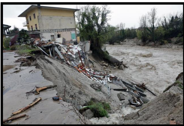
Figura 2.6 Violenta esondazione (ottobre 2018) con danni ad abitazioni e alla viabilità a Sedico (BL). (foto tratta da www.corrieredelveneto.it )
