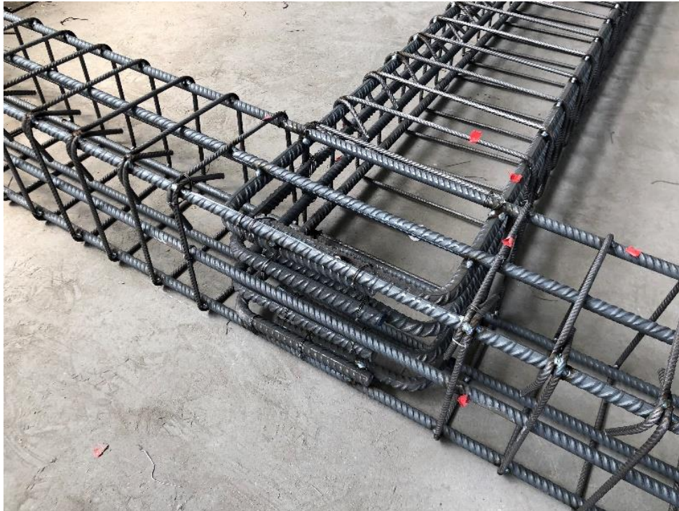
Figura 6-3: Gabbia d'armatura nodi 1 & 2
