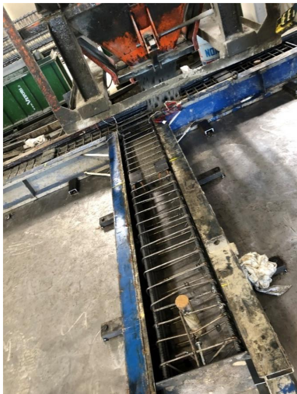
Figura 6-4: Posizionamento e fissaggio casseforme per il getto
