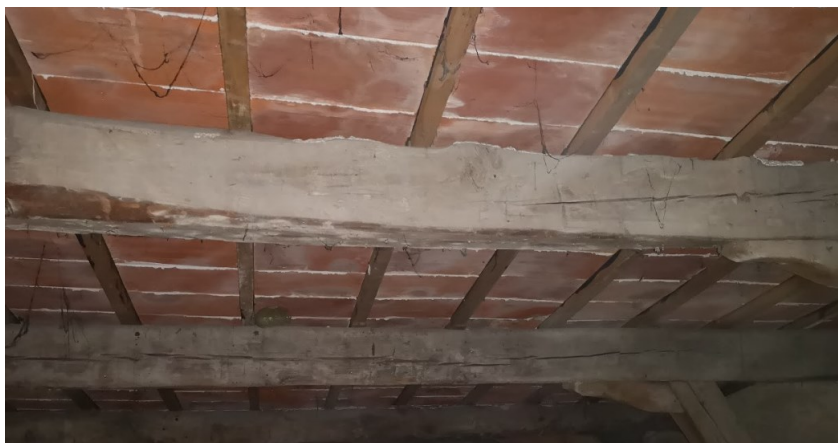
Figura 2.1.6: Sistema di copertura al di sopra delle volte minori lungo la navata.
