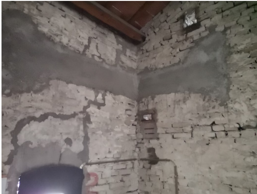
Figura 2.4.4: Foto dell'intervento eseguito.
