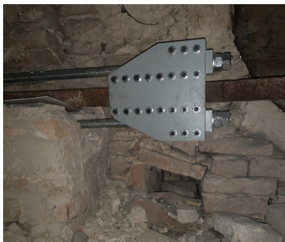
Figura 2.4.1: Riparazione del tirante spezzato.
