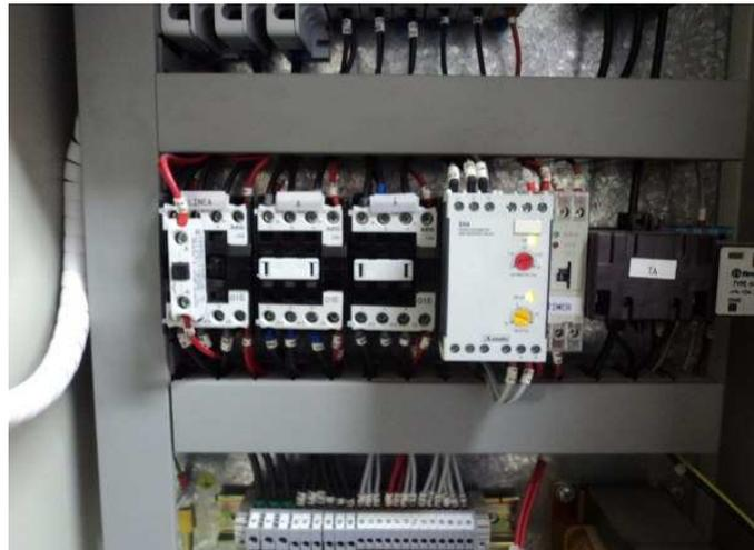
Fig. 3.4.1 Interfacce di potenza tra PLC e teleruttori (da electroyou.it)
