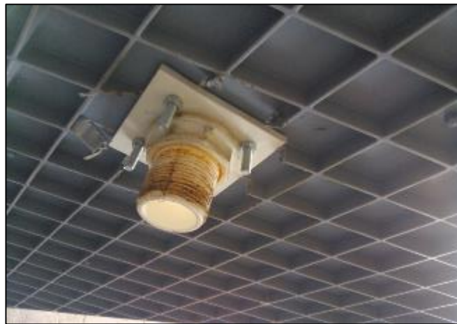
Figura 66 Dettaglio foro di scarico centrale
