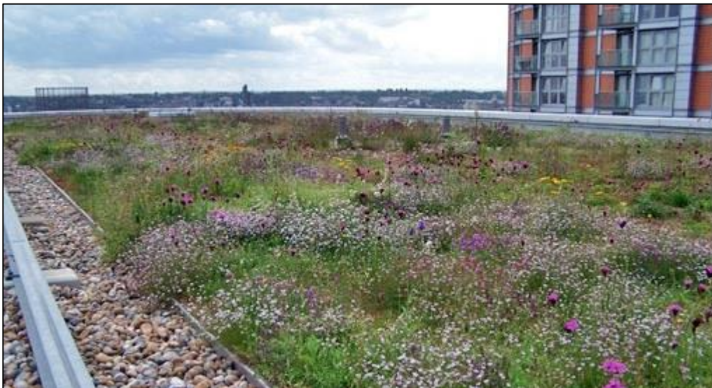
Figura 9 Esempio di tetto verde presso l'Hotel Radisson a Londra Fonte: (ZinCo Italia)
