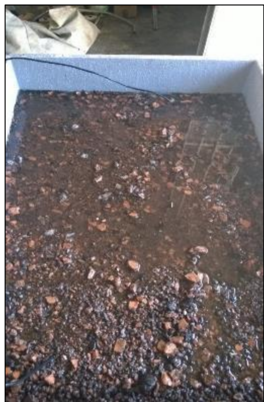
Figura 76 Difficoltà nell'infiltrazione dell'acqua al di sopra del substrato ZinCo in assenza dello strato drenante
