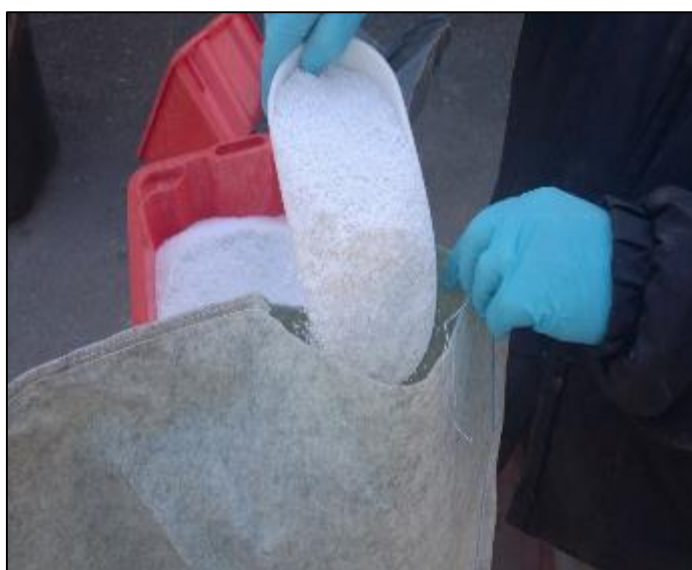
Figura 67 Sacchi di geotessile modificati e da riempire
