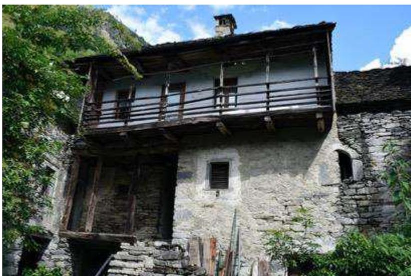
*Figura 19: Differenza tra ballatoio esterno in legno (piano superiore dell'edificio) e loggiato "incassato" (piano inferiore dell'edificio - Foto dell'autrice*
