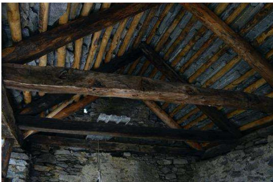
*Figura 13: : Esempio di ristrutturazione di un tetto a Veglio secondo le tecniche dell'architettura tradizionale (vista interna) – Foto dell'autrice*
