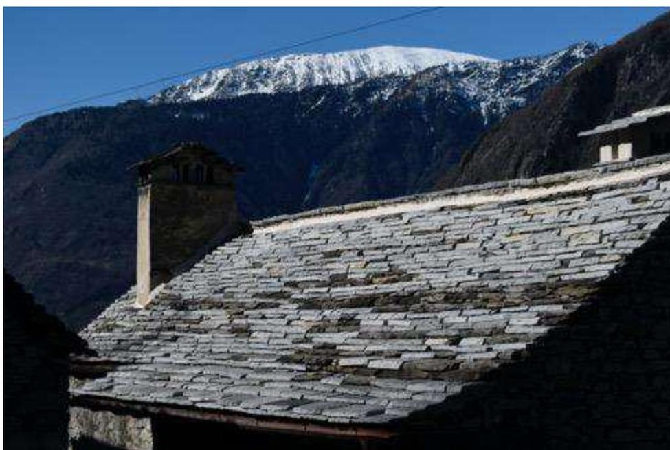
*Figura 6: Recente ristrutturazione di un tipico tetto in piode a Veglio – Foto dell'autrice*
