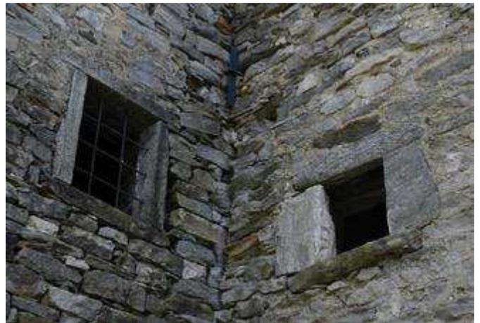
*Figura 16: Antica apertura con volta monolitica – Foto dell'autrice*
