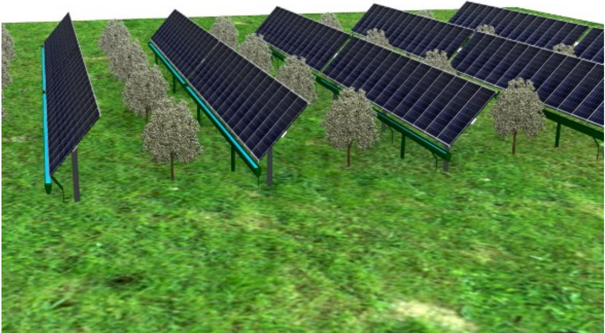
Figura 7 - Sistema Agro-Fotovoltaico con grondaia per il recupero dell'acqua
