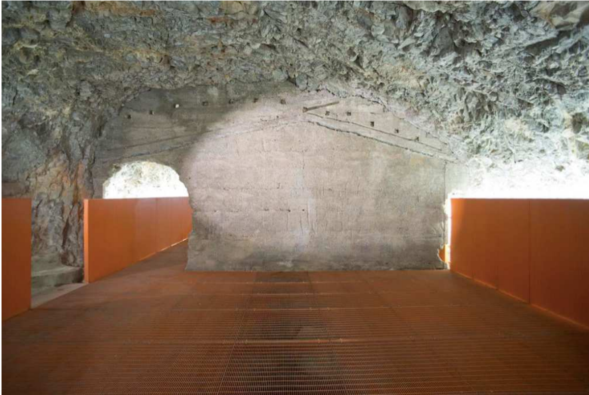
Figura 5: L'interno di una delle cavità del forte con la ricostruzione del pavimento contenente le baracche in legno. Fotografia di Anna Positano, Saggio Fotografico Forte Pozzacchio Valmorbia-Werk, da sentinella a messaggero, a cura di Chiara Comper e Stefano Bisoffi (Trento: IASA Edizioni, 2020).
