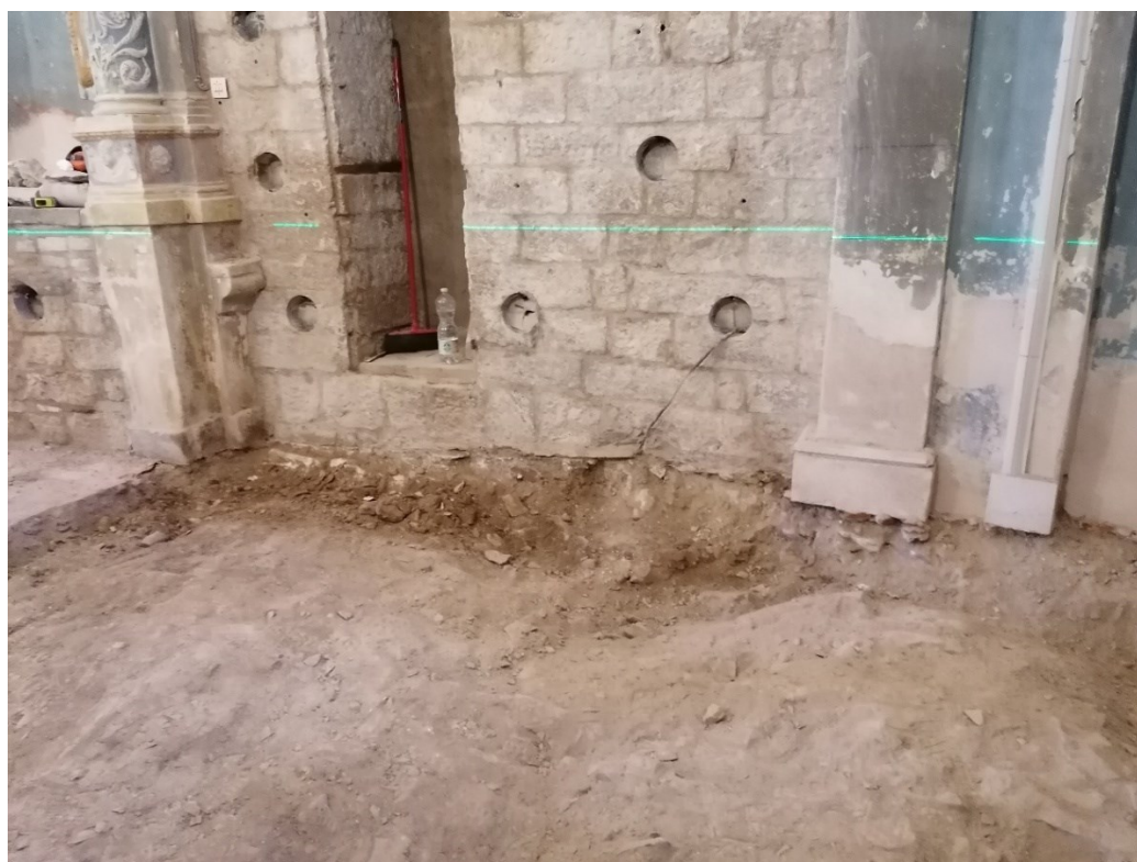
Fig. 24. Cupole 2 e 3 delle volte dopo rimozione del pavimento.
