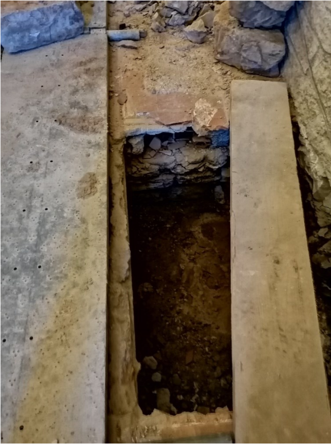
Fig. 22. Ampliamento dell'apertura iniziale.
