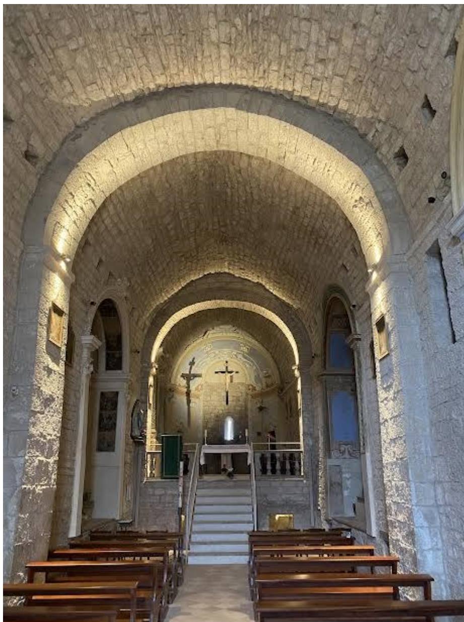
Interno della chiesa
