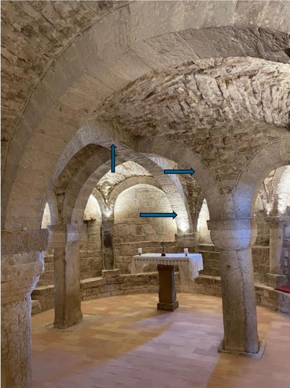
Fig. 7. Il costolone longitudinale e quello trasversale
