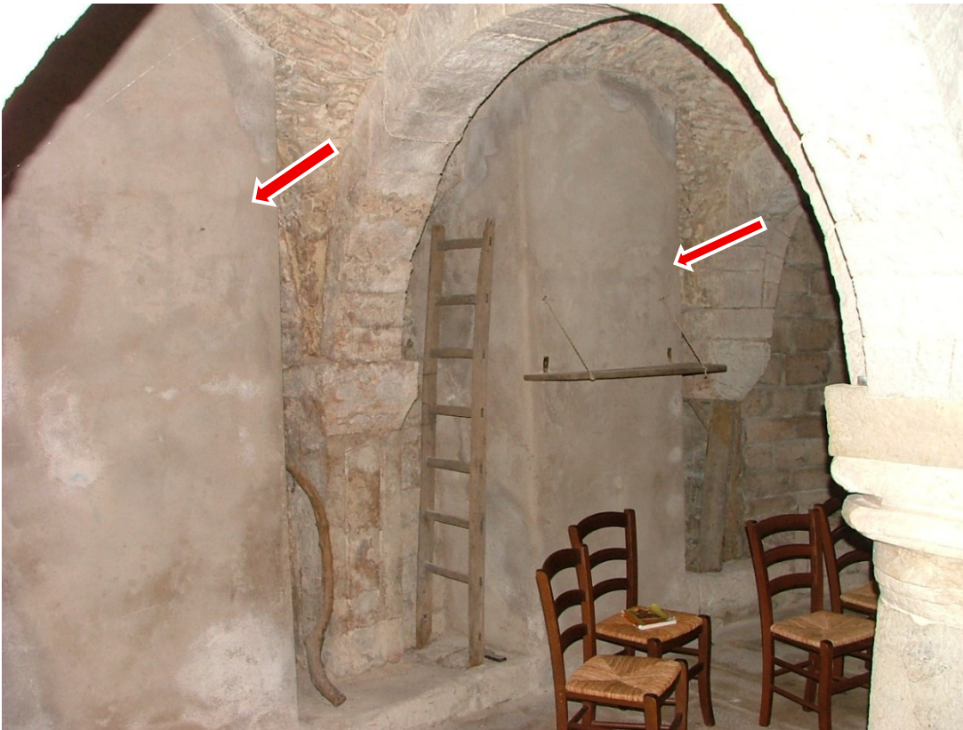
Fig. 20. Gli speroni in cemento armato.
