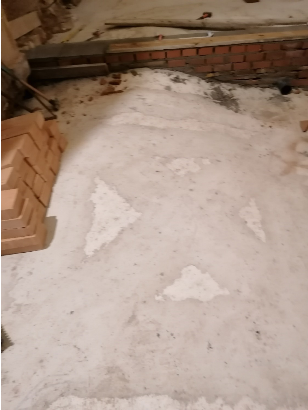
Fig. 33. Visione finale di una cupola prima del livellamento col massetto.
