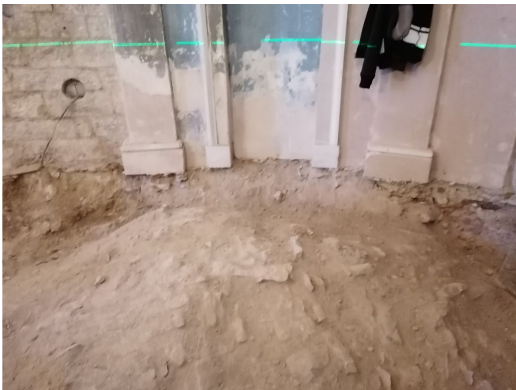
Fig. 23. Cupola 1 delle volte dopo rimozione del pavimento.
