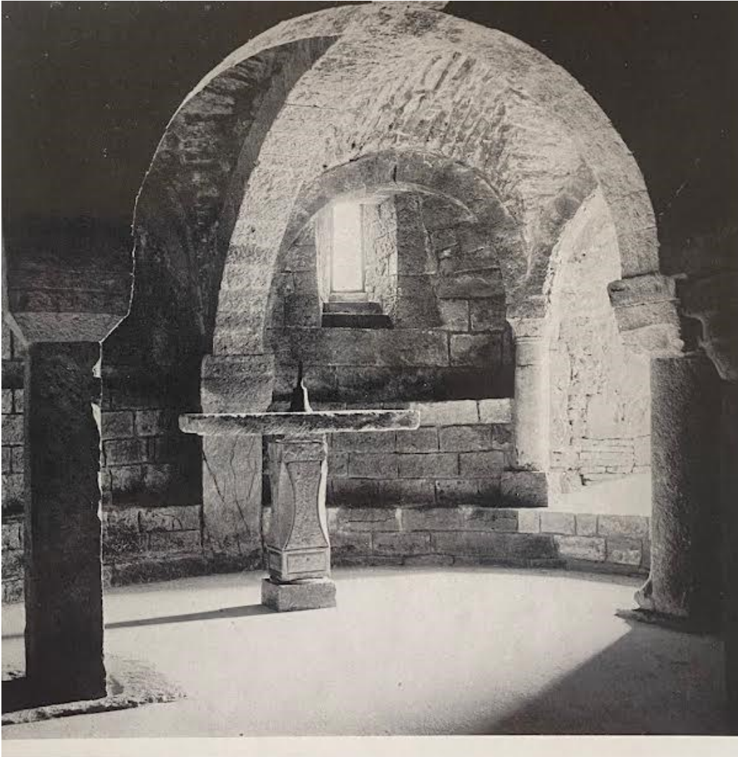
Fig. 3. La cripta ripulita con accesso laterale sotto il campanile.
