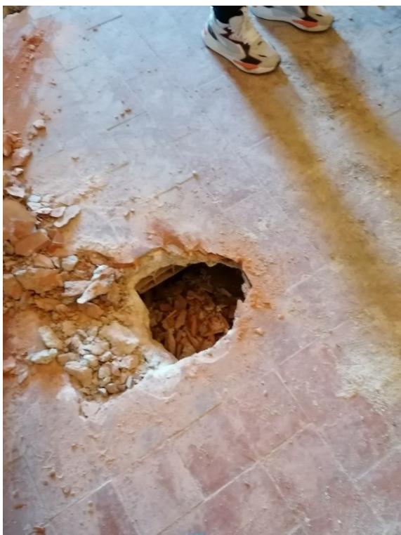
Fig. 21. Apertura iniziale sul pavimento del presbiterio della chiesa.
