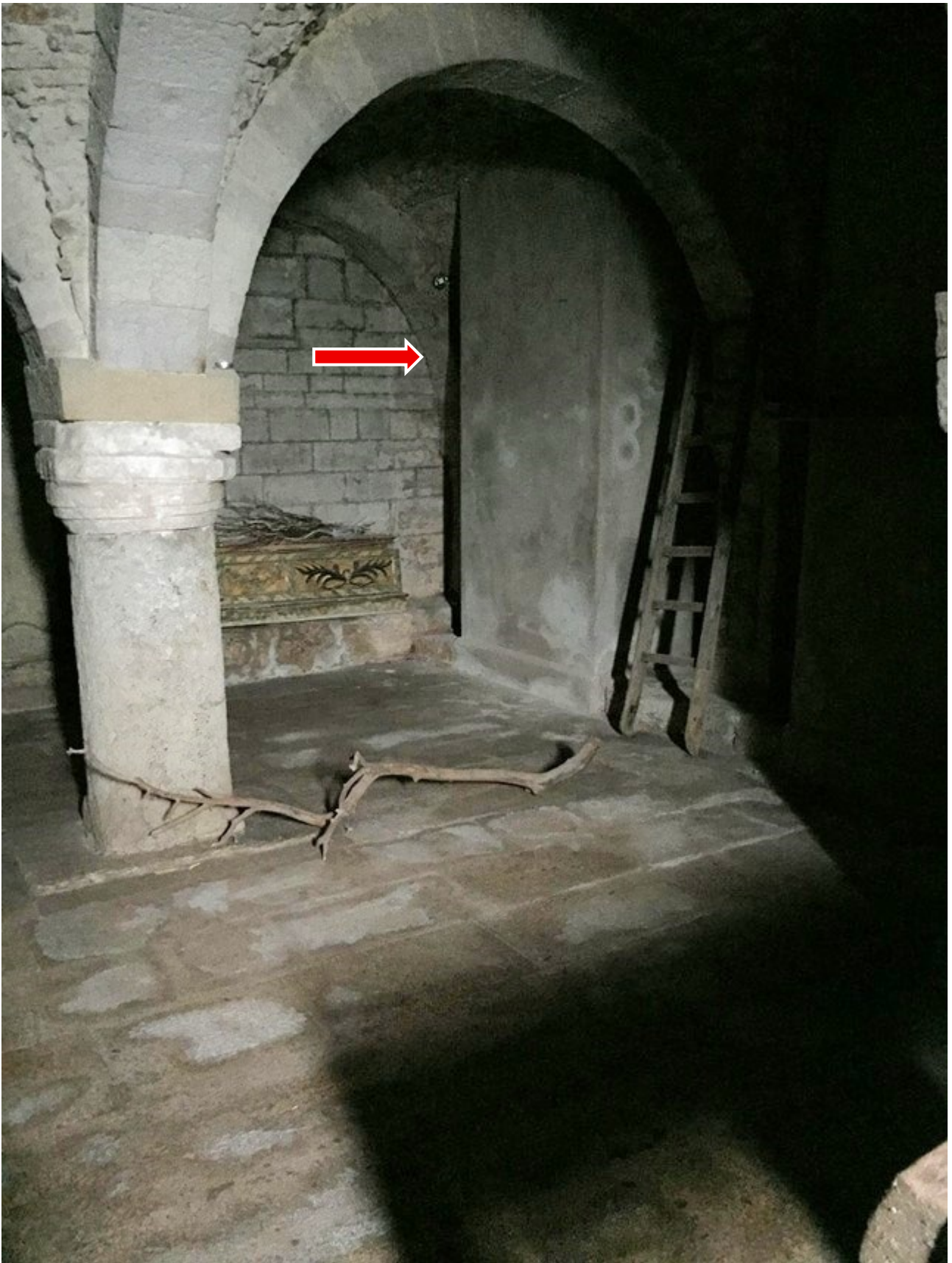
Fig. 18. Gli speroni in cemento armato.
