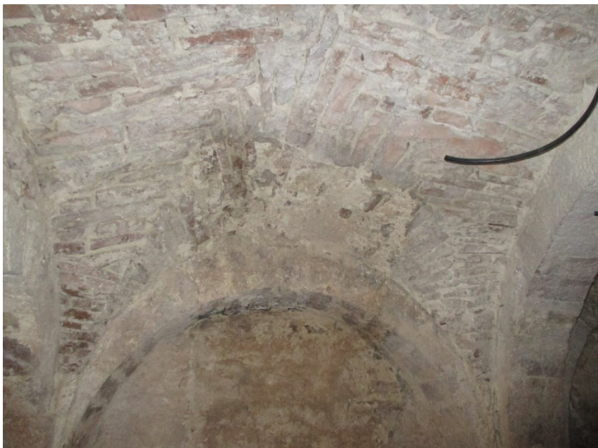
Fig. 34. Un trefolo che esce dalla volta.
