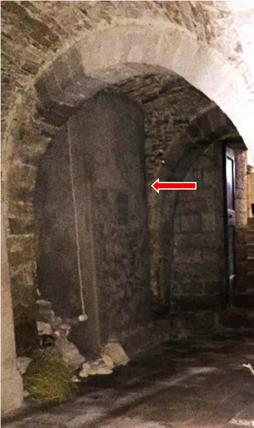
Fig. 19. Gli speroni in cemento armato.
