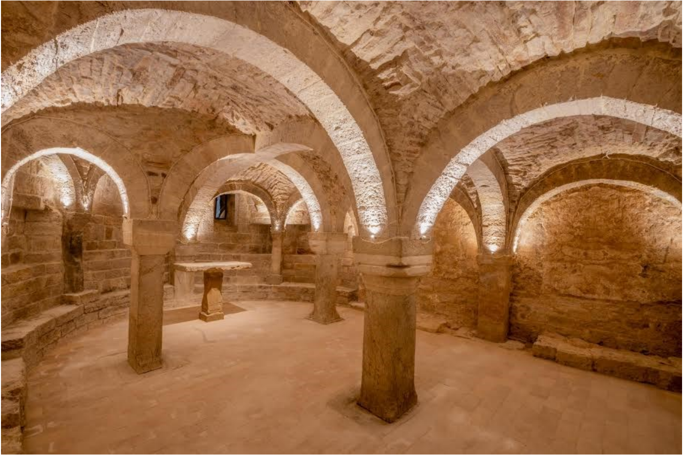
Fig. 37. La cripta oggi dopo i lavori di restauro e consolidamento.
