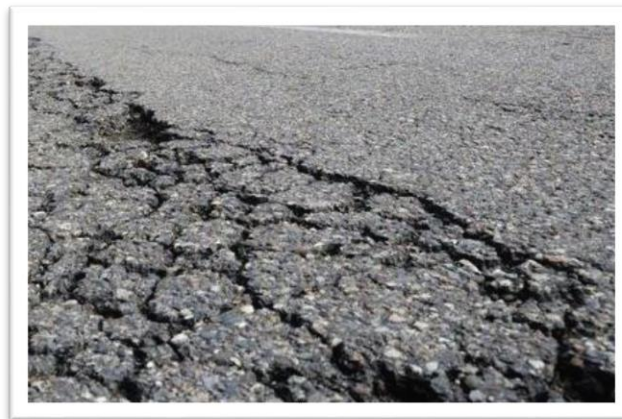
Figura 12: fessurazione ramificata
