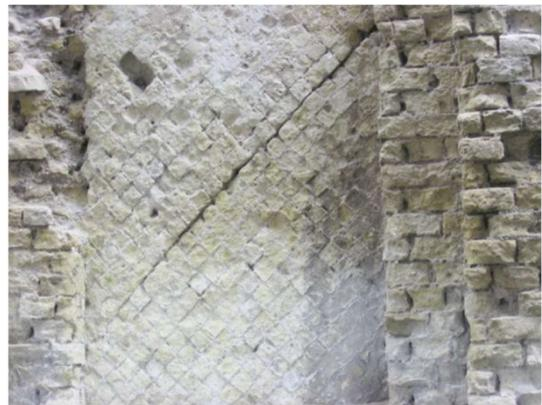
Fig. 23 Particolare del prospetto della terza terrazza del teatro romano di Verona con il paramento di un muro in opera reticolata (CAVALIERI MANASSE 2015, p. 207).
