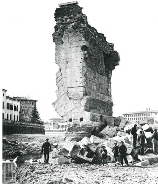
*Fig. 25 Rovine del ponte della Pietra di Verona: dalla foto si evincono chiaramente le dimensioni di blocchi di calcare ammonitico impiegati nella costruzione (BASSI 1999, p. 83).*
