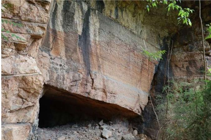
*Fig. 56 Particolare di una porzione della parete di fondo della Cava 64: si notano chiaramente le tracce di cavatura dei blocchi e una porzione di cava in galleria aperta in corrispondenza di una frattura verticale del giacimento.*
