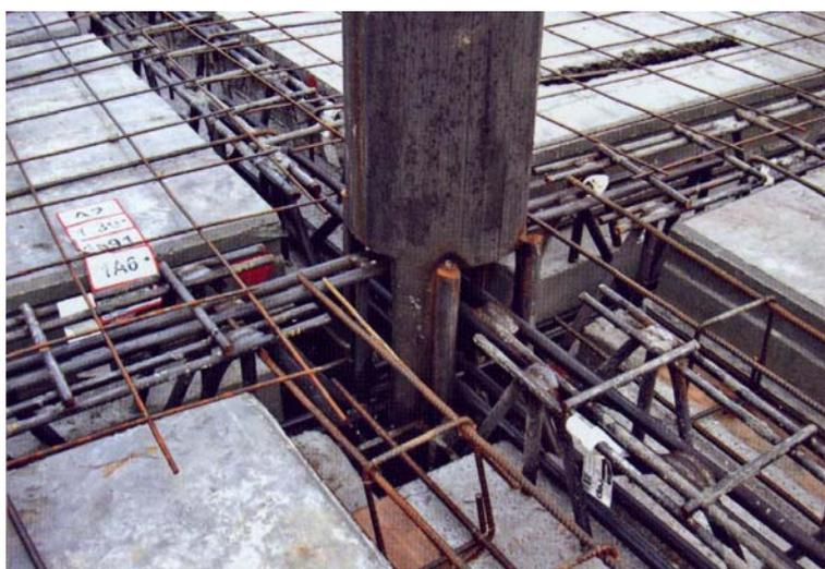
*Figura 24. Disposizione armature per realizzare continuità in due direzioni*
