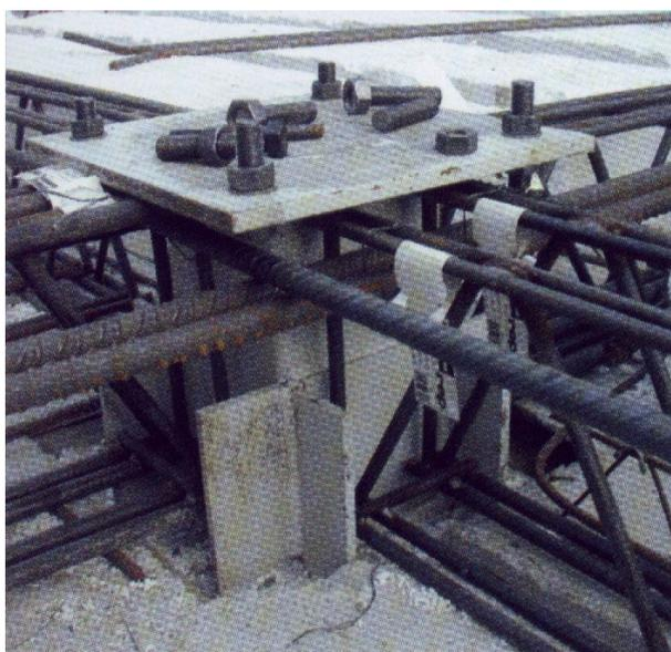
Figura 28. Dettaglio di connessione pilastro flangiato
