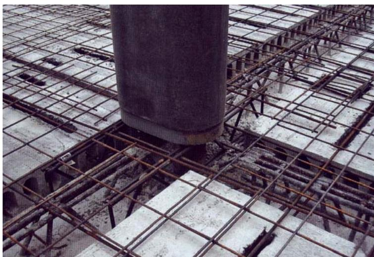
*Figura 30. Dettaglio di connessione pilastro centrifugato*
