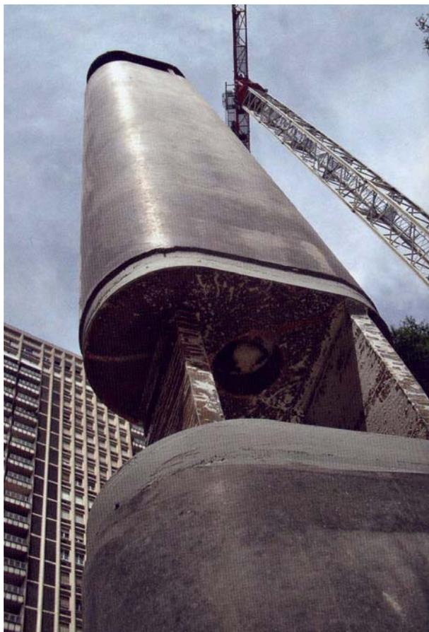
*Figura 29. Pilastro centrifugato*
