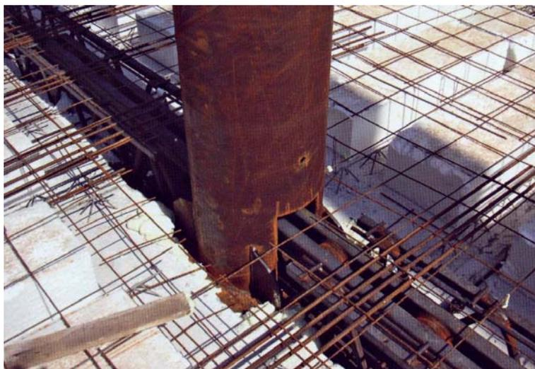
*Figura 23. Disposizione armature per realizzare continuità in una direzione*
