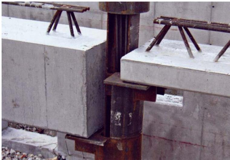
*Figura 26. Dettaglio di connessione per travi di diversa luce*
