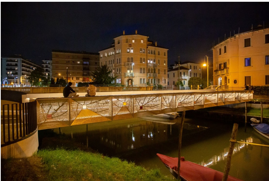
Figura 9 | Ponte ciclopedonale di Piazzale Cialdini a Mestre in notturna Foto di Stefano Marchiante
