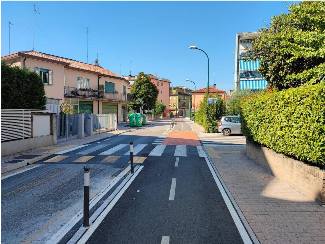
Figura 42 | Nuovo tratto di percorso ciclabile in via Rielta con paletti dissuasori realizzato nel 2022
