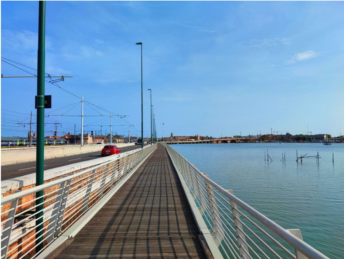
Figura 13 | Passerella ciclopedonale a sbalzo lungo il ponte translagunare
