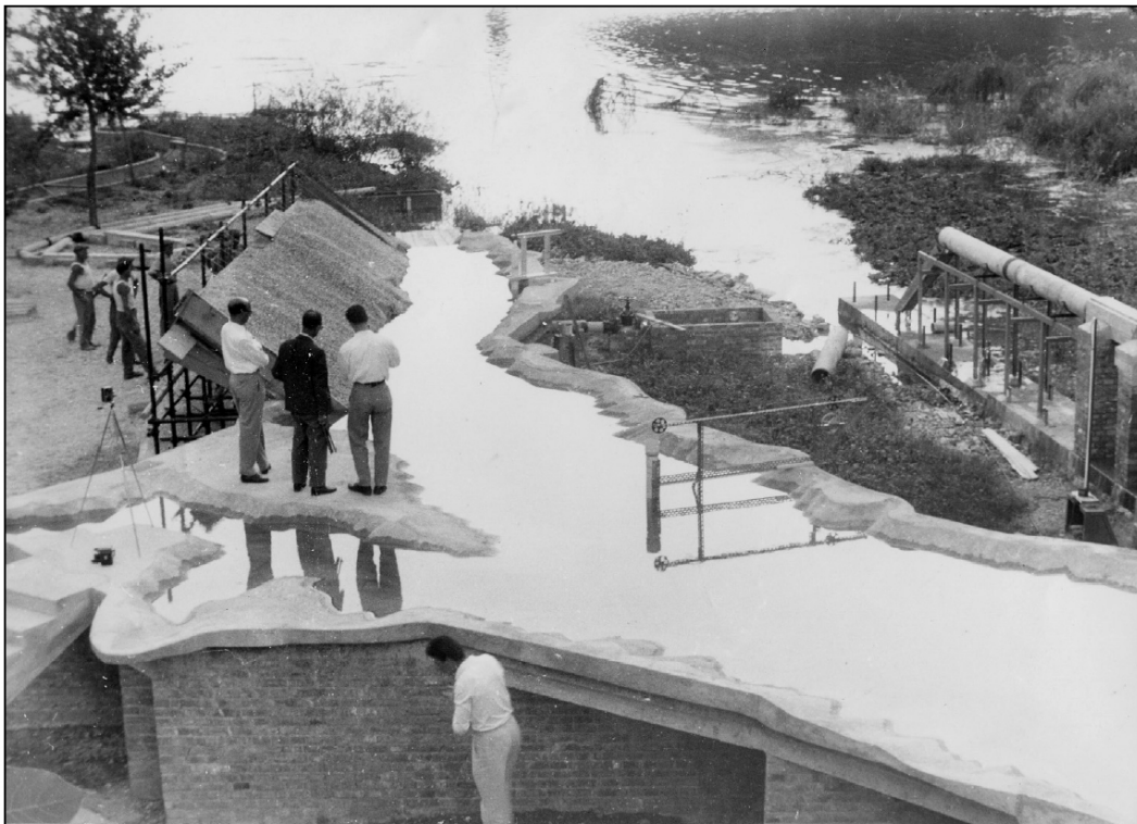
Figura 1.6: Vista da monte del modello di Nove, si può notare la ghiaia in sinistra del bacino con cui si simulava la frana, nello specifico si nota come fosse studiato ancora con il piano inclinato.
