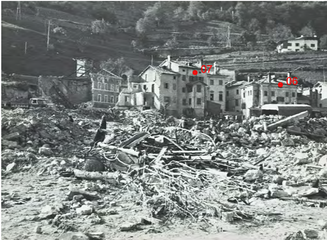
Figura 2.3: Vista del municipio di Longarone 06, con gli edifici limitrofi crollati.
