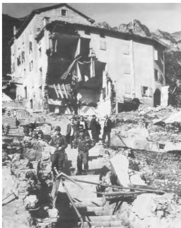
(b) Fabbricato in zona Murazzi, con danni importanti ad un'ala, mentre l'altra con scuri aperti e vetri integri.
