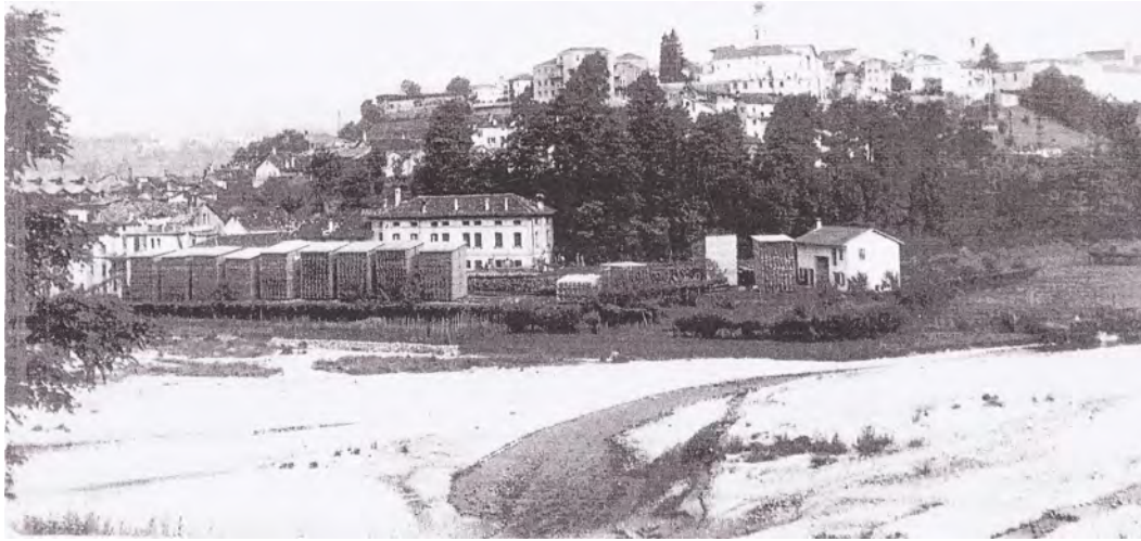
Figura 2.8: Immagine delle segherie bellunesi prima del disastro, sono identificate nella planimetria nell'allegato XXXX in appendice
