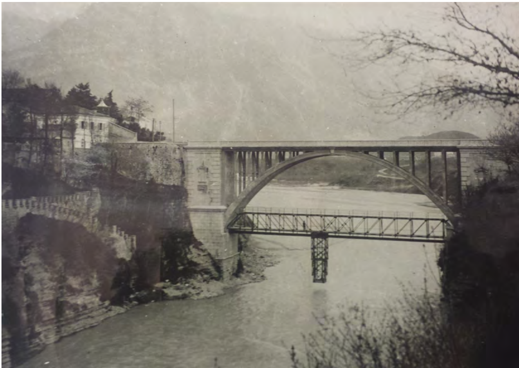
Figura 2.7: Immagine del Ponte di Ponte nelle Alpi prima del 9 ottobre 1963, in cui è presente la passerella per misurazioni idrografiche.
