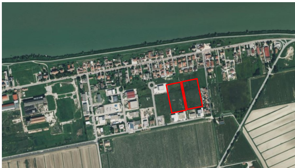
Figura 6 Posizionamento dei due impianti fotovoltaici da 999 kW ciascuno
