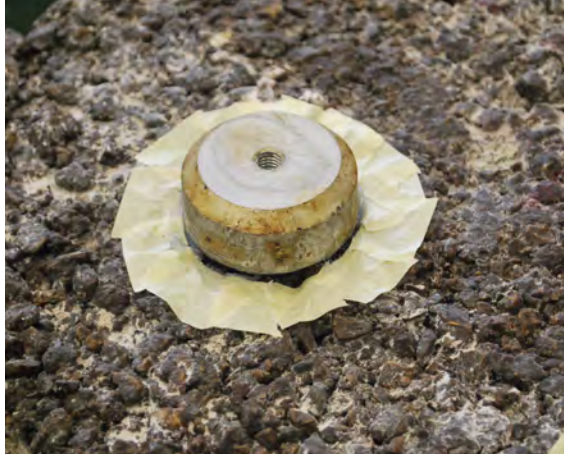
Figura 4.36: tassello metallico incollato.
