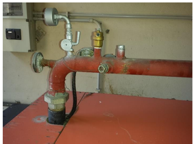
Figure 24 e 25: Particolari della rete di distribuzione in centrale termica: da notare la totale assenza di isolante nelle tubazioni.
