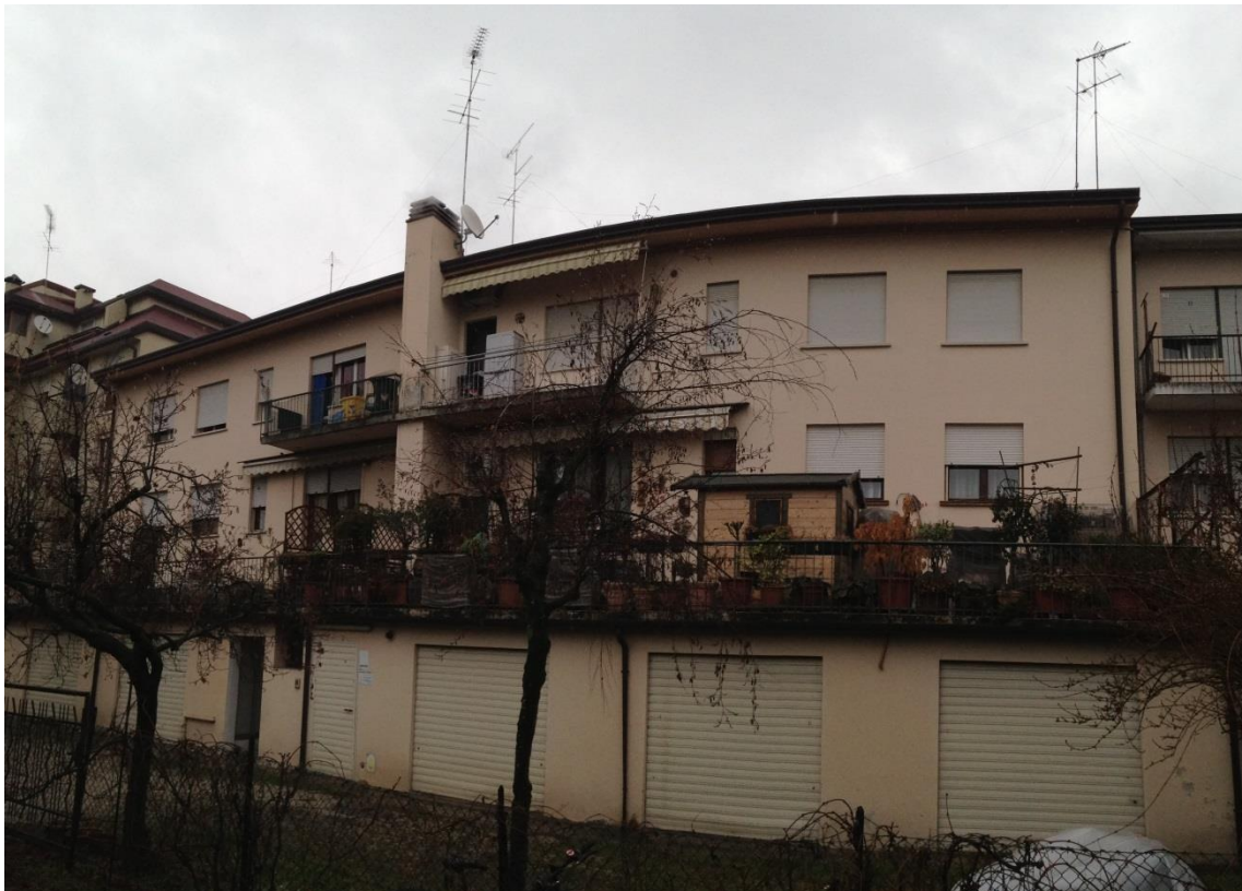
Figura 16: Vista del lato posteriore del condominio, dove si notano i box auto, e il camino della centrale termica.
