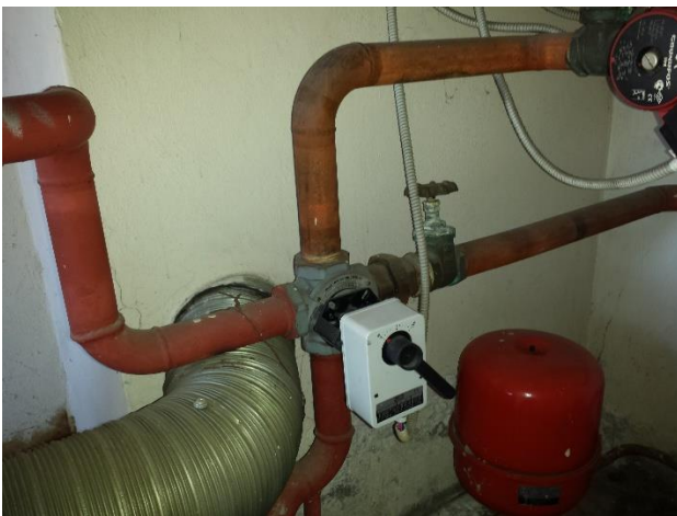
Figure 24 e 25: Particolari della rete di distribuzione in centrale termica: da notare la totale assenza di isolante nelle tubazioni.
