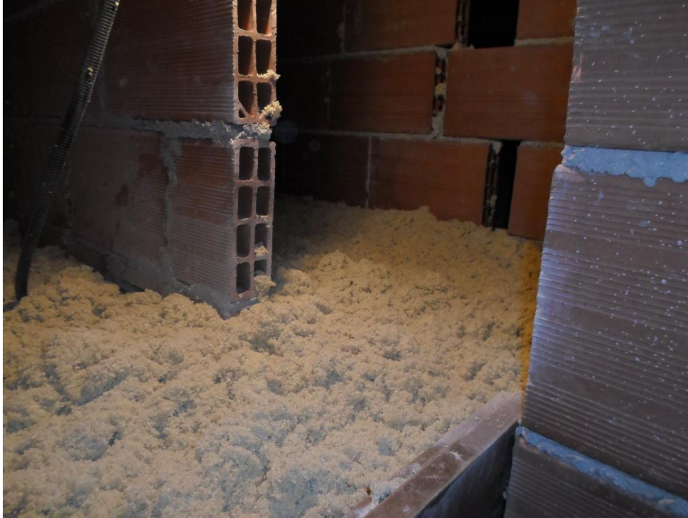
Figura 50: Fotografia di un sottotetto generico dopo la posa dello strato isolante di fiocchi di cellulosa
