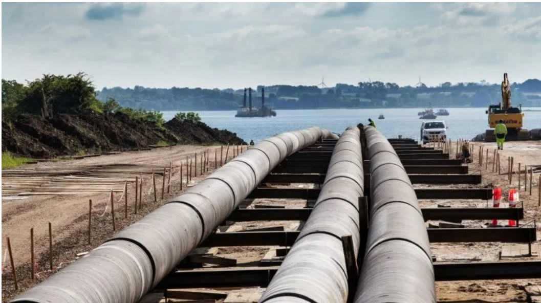
Figura 20. Idrogenodotto tra Germania-Norvegia in costruzione (03/2022)
