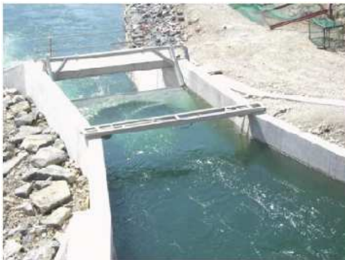
Figura 4-Turbina VLH durante il funzionamento.
