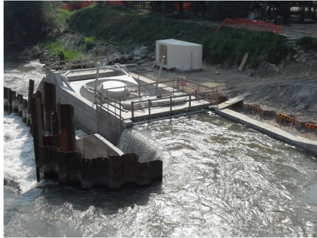
Figura 17-Vista del canale derivatore quando la paratoia è chiusa.
