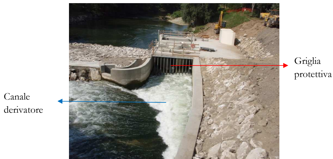
Figura 15-Vista del canale derivatore e della griglia protettiva.
