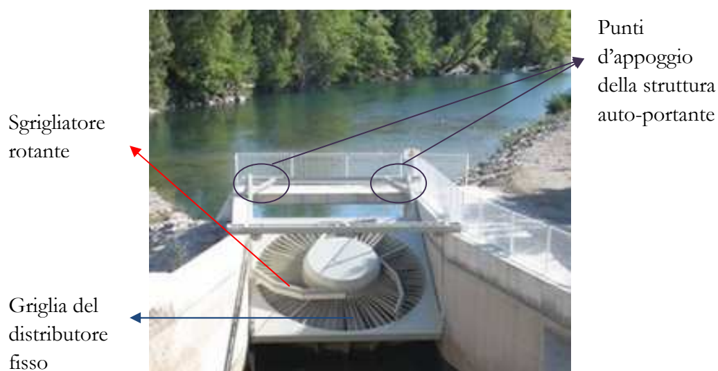
Figura 3-Turbina VLH, vista frontale.
