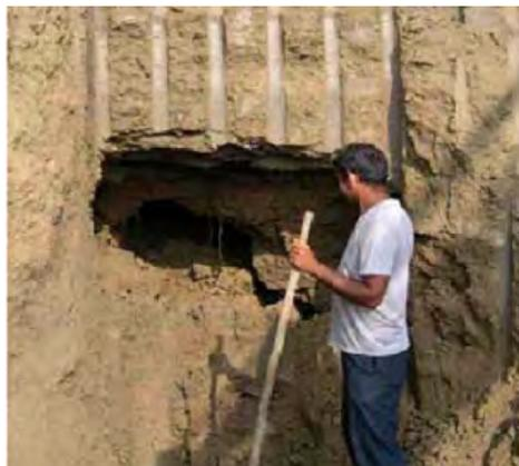
**Fig. 4.22** - Esempio di grande cavità all'interno di un tratto arginale, individuabile con tecniche geofisiche;
