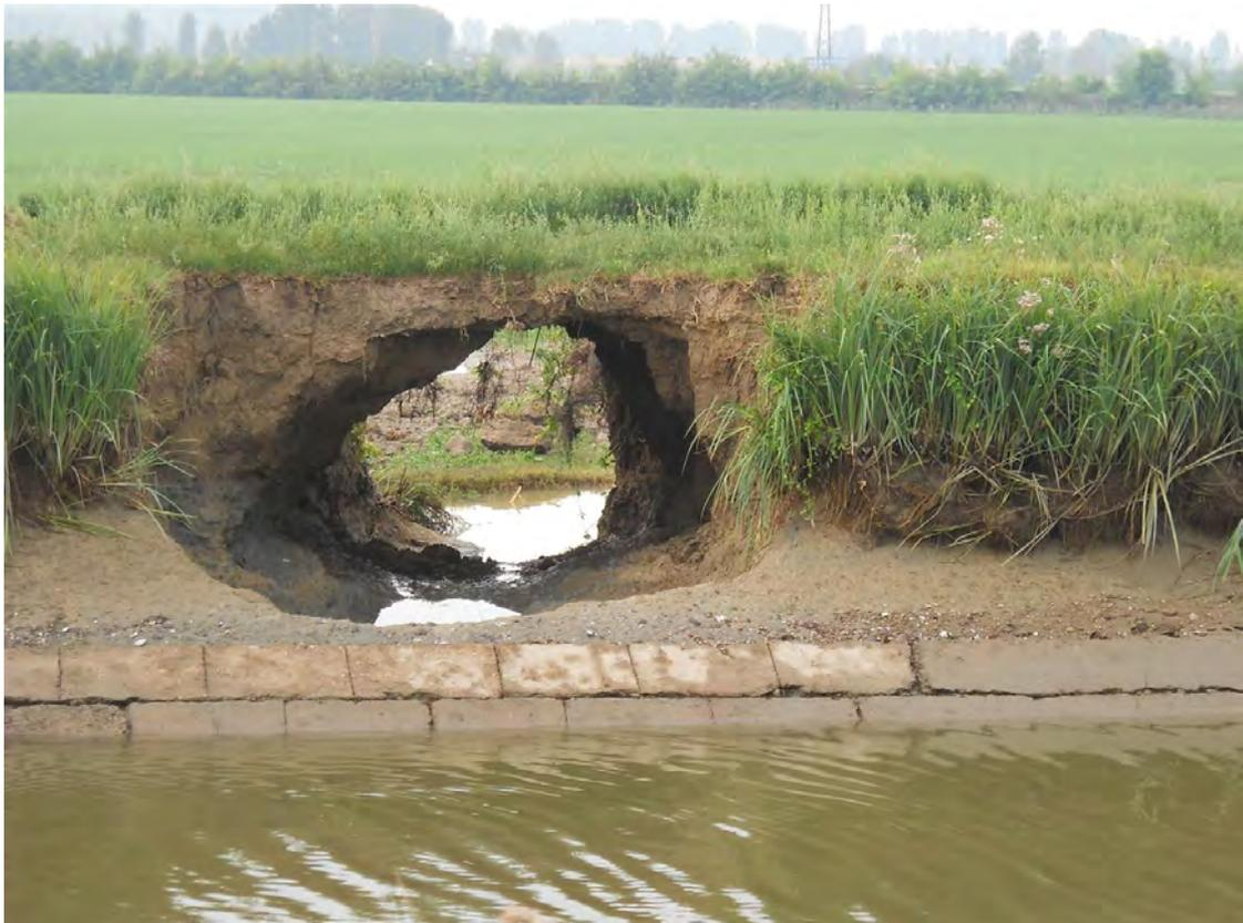
Fig. 4.21 - Esempio di collasso arginale interno. 2011 a Sabbioncello (MN);
