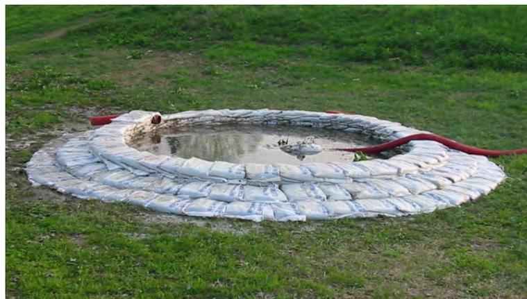
Fig. 3.10 - Fontanazzo. Il perimetro viene innalzato con sacchi di sabbia così da innalzare il livello liquido sul fronte campagna e ridurre il gradiente idraulico instauratosi;
