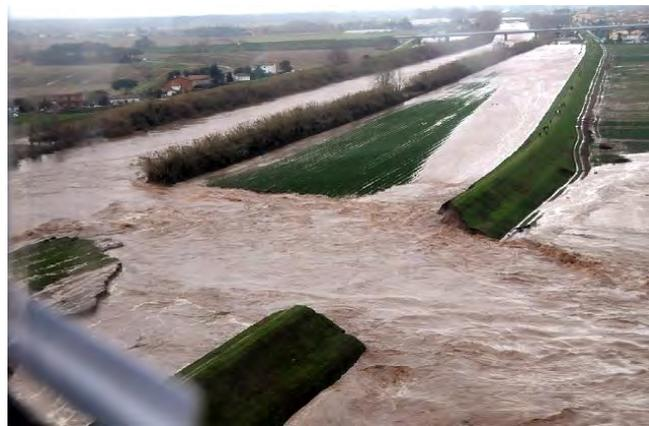
**Fig. 3.6** - A sinistra: Sormento dell'argine argine del Canale Terrazzo a Terlara (PD), 2014;
