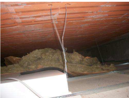
Fig. 4.12. Primo orizzontamento rilievo strutturale
