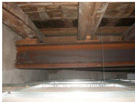
Fig. 4.13. Primo orizzontamento rilievo strutturale
