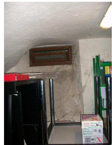
Fig. 4.23. Copertura interrato rilievo strutturale
