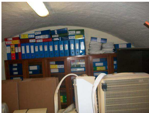
Fig. 4.22. Copertura interrato rilievo strutturale
