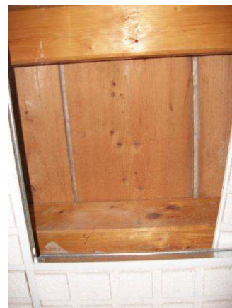
Fig. 4.17. Primo orizzontamento rilievo strutturale
