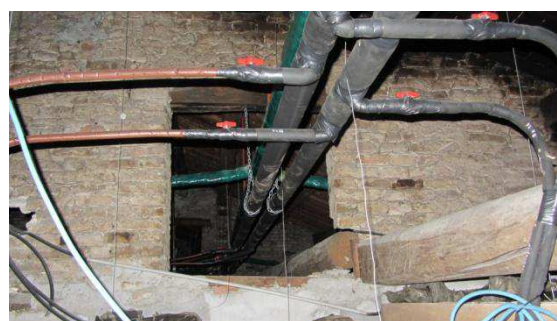
Fig. 4.47. Copertura blocco est
