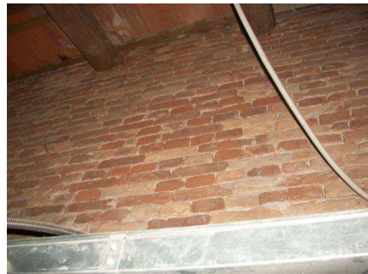
Fig. 4.49. Muratura blocco nord
