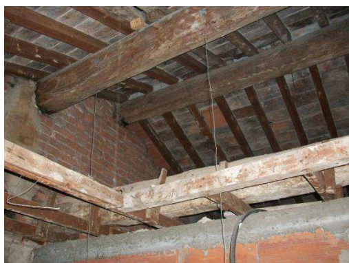
Fig. 4.40. Copertura blocco est
