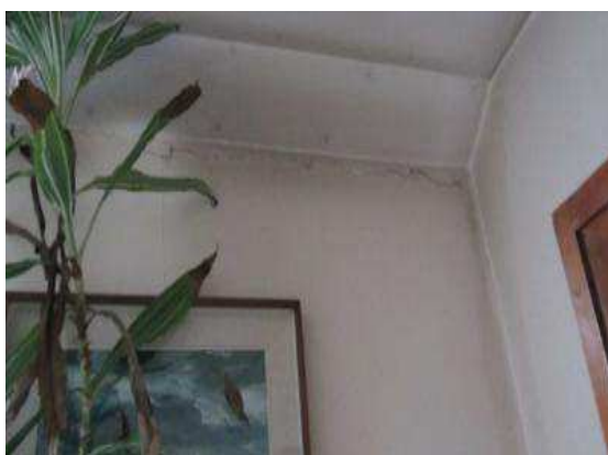
Fig. 4.41. Lesione su solaio
