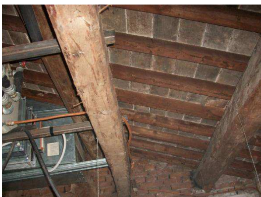
Fig. 4.37. Copertura blocco est
