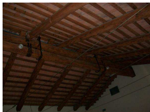
Fig. 4.38. Copertura blocco est
