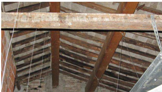
Fig. 4.1.43. Copertura blocco est
