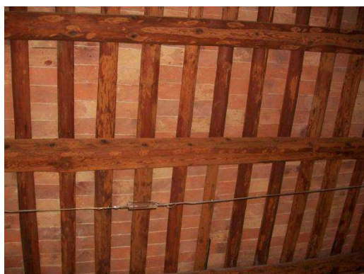
Fig. 4.34. Copertura blocco nord
