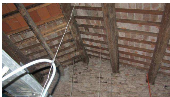
Fig. 4.46. Copertura blocco est
