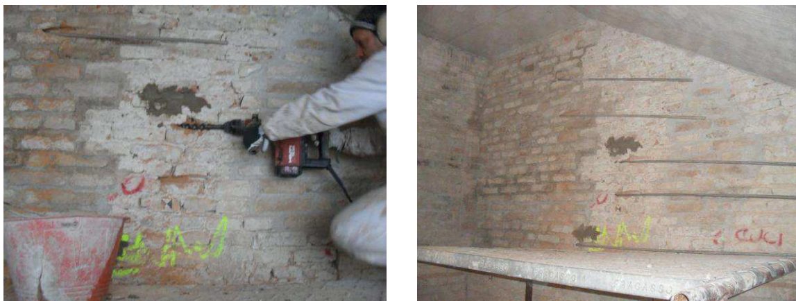
Fig. 4.35. Interventi di cucitura
