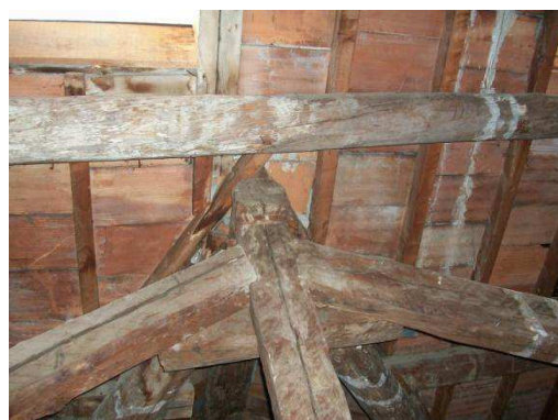
Fig. 4.41. Copertura blocco est
