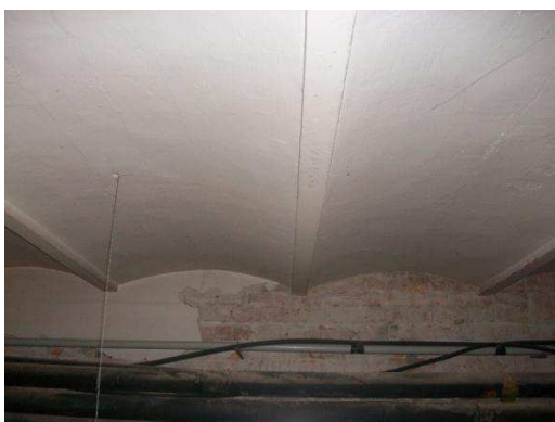
Fig. 4.9. Solaio voltine laterizio sostegni acciaio
