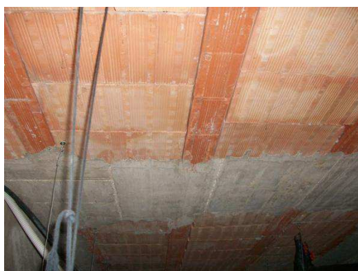
Fig. 4.28. Secondo orizzontamento trave in porzione di latero-cemento
