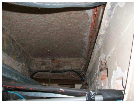
Fig. 4.35. Copertura blocco nord
