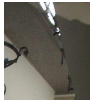
Fig. 4.14. Primo orizzontamento rilievo strutturale
