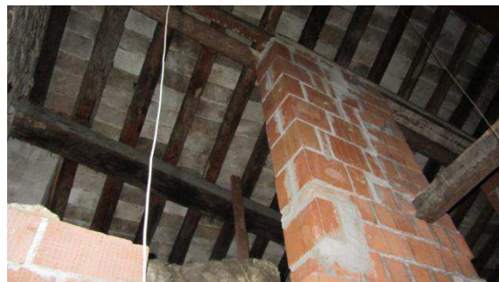
Fig. 4.1.44. Copertura blocco est
