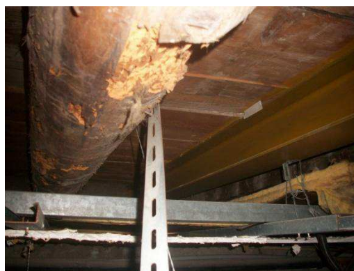
Fig. 4.10. Solaio ligneo e rinforzo in acciaio
