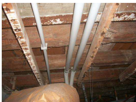
Fig. 4.16. Primo orizzontamento rilievo strutturale
