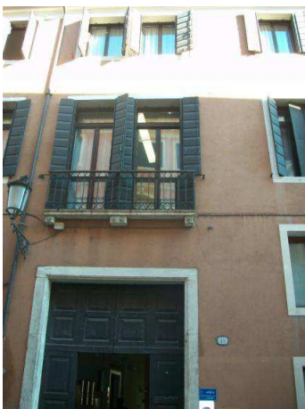
Fig. 1.4. Ingresso da via del Santo
