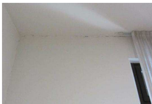
Fig. 4.33. Lesioni su solaio
