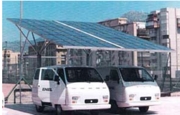
Fig. 8.1 Pannelli fotovoltaici per la ricarica dei veicoli elettrici
