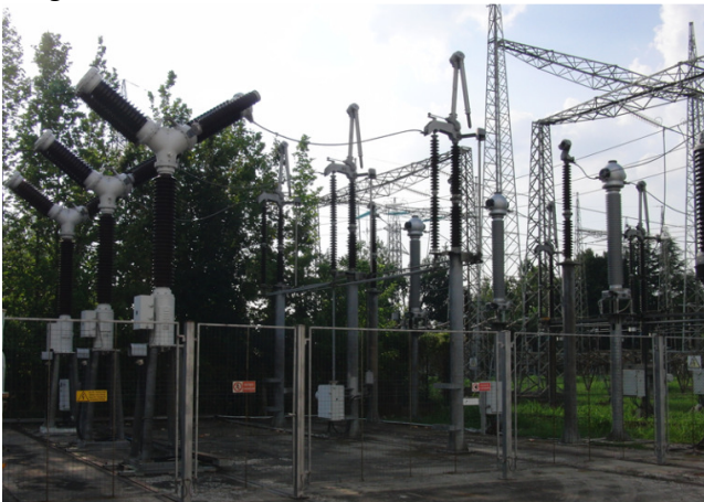
Fig.52: stallo di arrivo linea del Laboratorio SVEPPI
