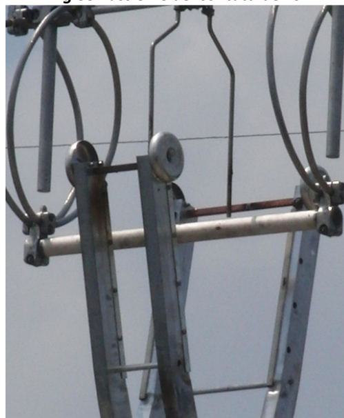
Fig.35: assieme dei contatti dell'SX
