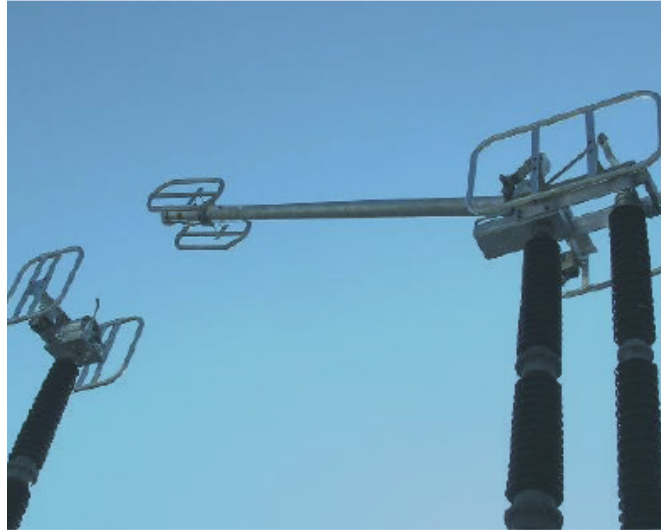
Fig.3: esempio di sezionatore ad interruzione verticale
