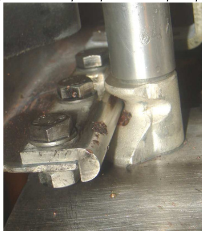
Fig.32: contatti principali S2DA dopo la prova
