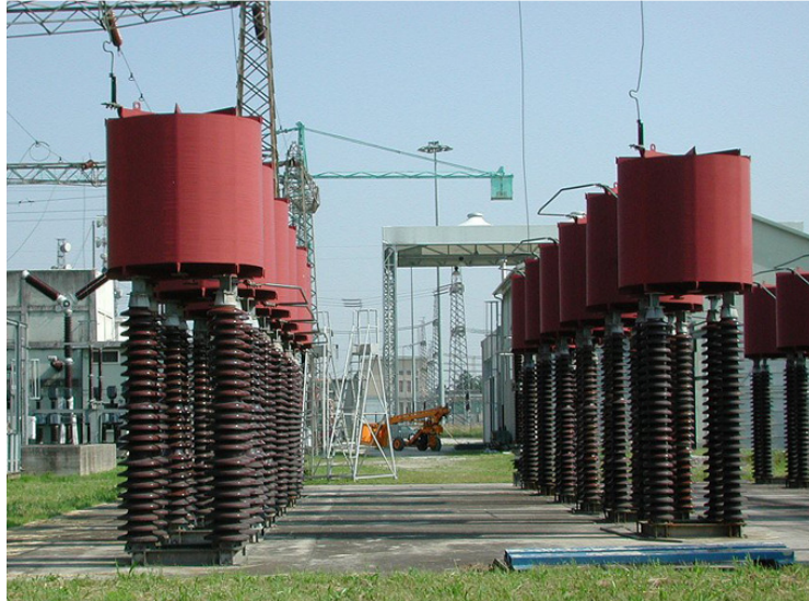
Fig.54: Reattanze di regolazione lato AT
