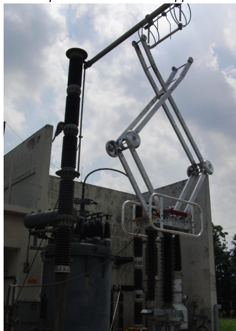
Fig.6: esempio di sezionatore a doppia interruzione
