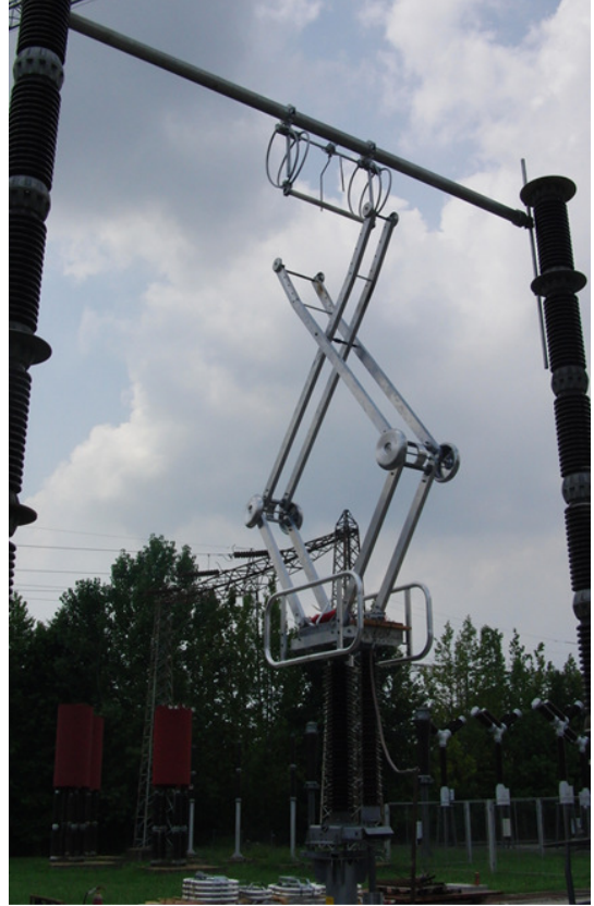
Fig.38: dispositivo di aggancio alla sbarra dei contatti mobili secondari
