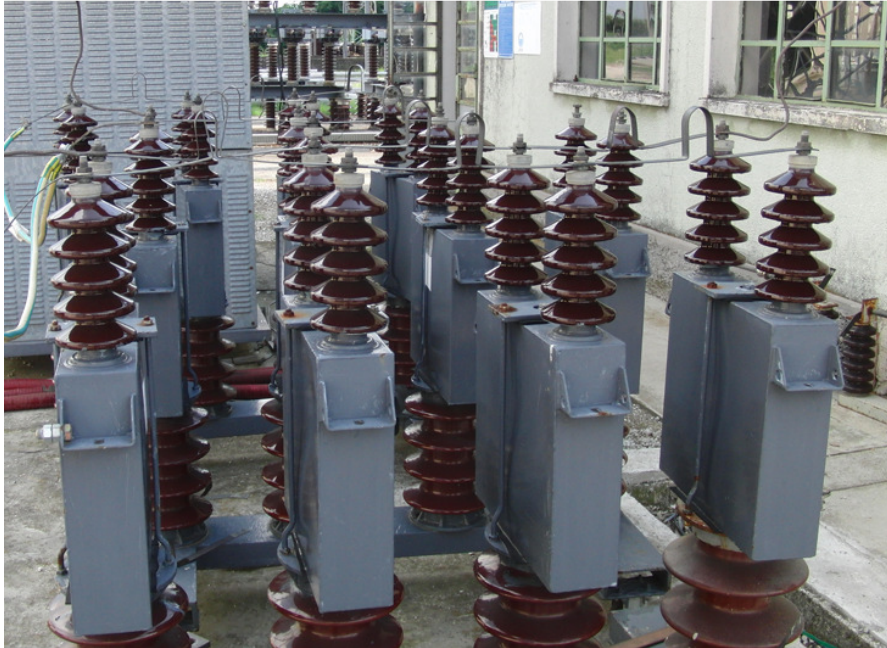
Fig.56: condensatori utilizzati (100 nF ciascuno)
