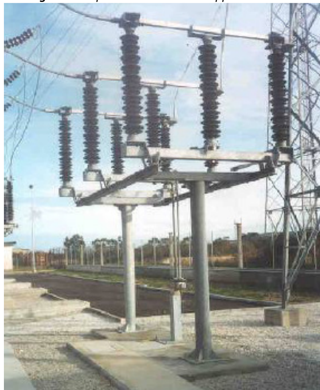
Fig.5: esempio di sezionatore a doppia interruzione
