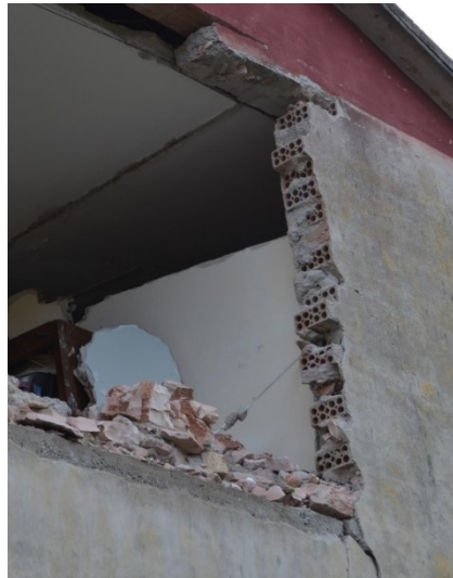
Figura 4.18: Sezione muratura blocchi forati (Valluzzi et al., 2020).
