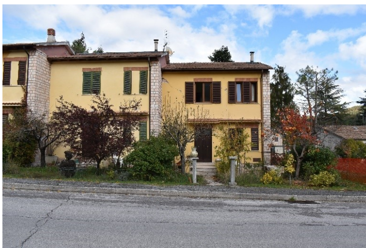
Figura 4.3 : Porzione Sud edificio a schiera (Valluzzi et al.,2020).
