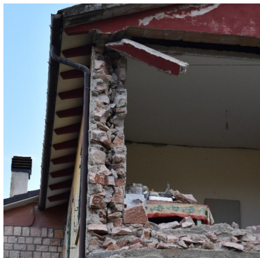
Figura 4.15: Sezione muratura pietrame irregolare (Valluzzi et al.,2020).
