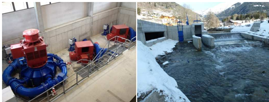
Fig.4.1: a sinistra 3 macchine dell'impianto di Temù: una ad asse verticale e due ad asse orizzontale. A destra l'esterno e il salto
