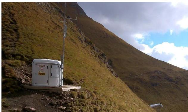
**Fotografia 5.1** Gazex con deposito in primo piano lungo il "Viel del Pan" Passo Pordoi - Passo Fedaia.
