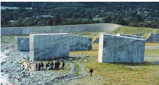
**Figura 5.4** Difesa passiva: opere di deviazione e sullo sfondo opera d'arresto
