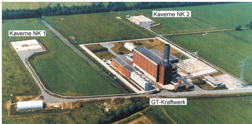
Fig. 3.12. Veduta aerea dell'impianto CAES di Huntorf (Germania).
