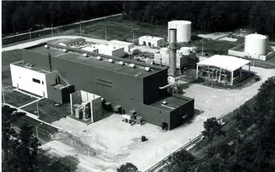
Fig. 3.15. Veduta aerea dell'impianto CAES di McIntosh (Alabama, USA).
