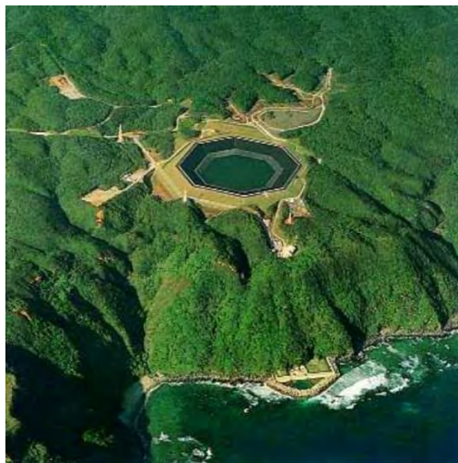
Fig. 3.5. Impianto di pompaggio marino di Okinawa (Giappone).
