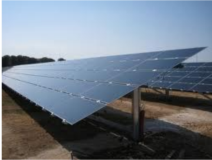
Fig. 9.4: Sostegno ad inseguimento monoassiale
