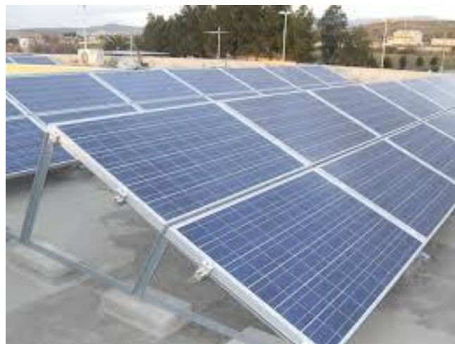
Fig. 9.1: Struttura di sostegno a cavalletto
