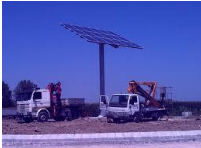
Fig. 9.2: Struttura di sostegno a palo
