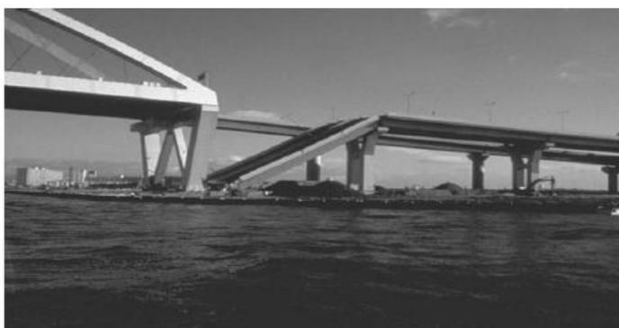
Figura 4.2: Esempio di perdita di appoggio dell'impalcato con resistenza della sovrastruttura.
