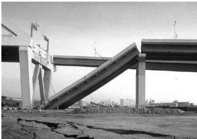
Figura 4.1: Esempio di perdita di appoggio dell'impalcato a seguito di un evento sismico.
