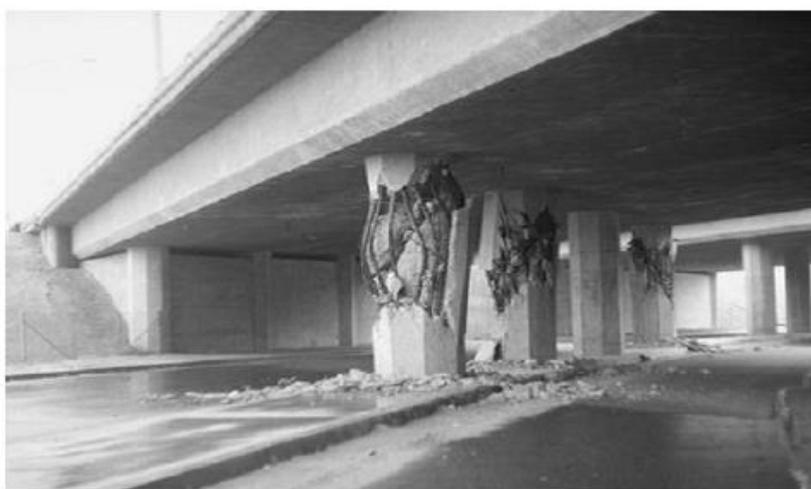
Figura 4.6: rotture per presso-flessione delle pile e mancanza di staffatura.
