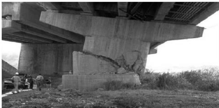
Figura 4.4: rottura per taglio di una pila.
