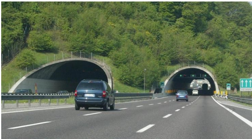
Figura 1.1: la galleria dei Colli Berici, situata tra le uscite dell'autostrada A4 di Vicenza Est e Vicenza Ovest, è un tipico esempio di galleria a doppio fornice.
