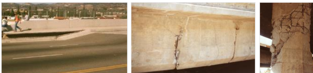
Figura 2.2 - Ponti: Danni di tipo moderato.
