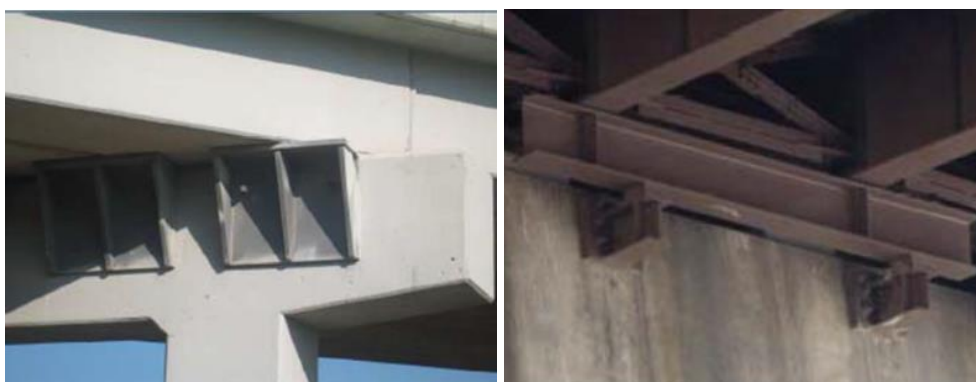
Figura 2.9 - Esempi di allungamento delle zone di appoggio.
