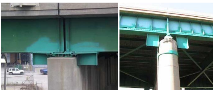
Figura 2.10 - Esempio di ritegni longitudinali e trasversali.
