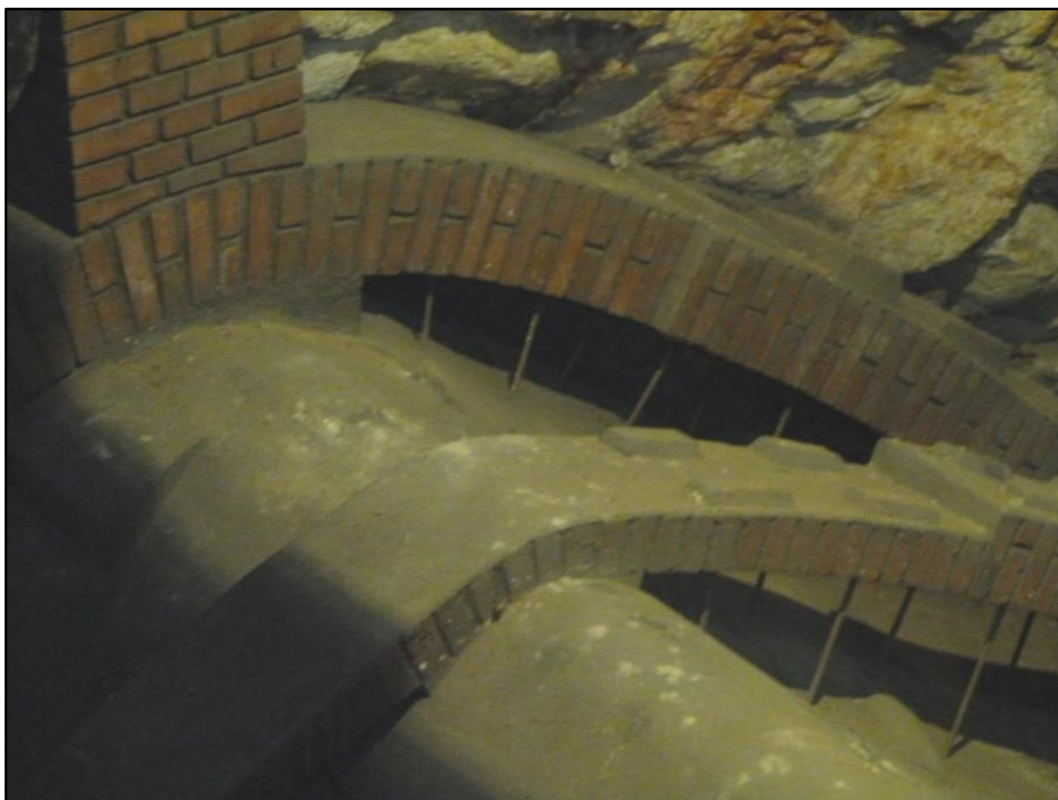
Fig. 5: particolare degli archi di rinforzo locale a cui è appesa la volta tramite tirantini metallici
