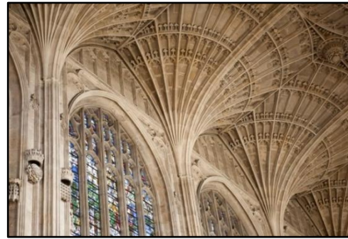
Fig. 54a-52b: volta a ventaglio tipo (sinistra); esempio della King's College Chapel in Cambridge (destra)
