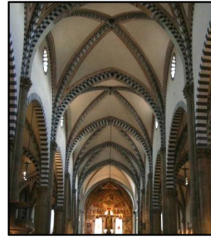
Fig. 53a-51b: volta a crociera tipo (sinistra); esempio della chiesa di S.Maria Novella a Firenze (destra)
