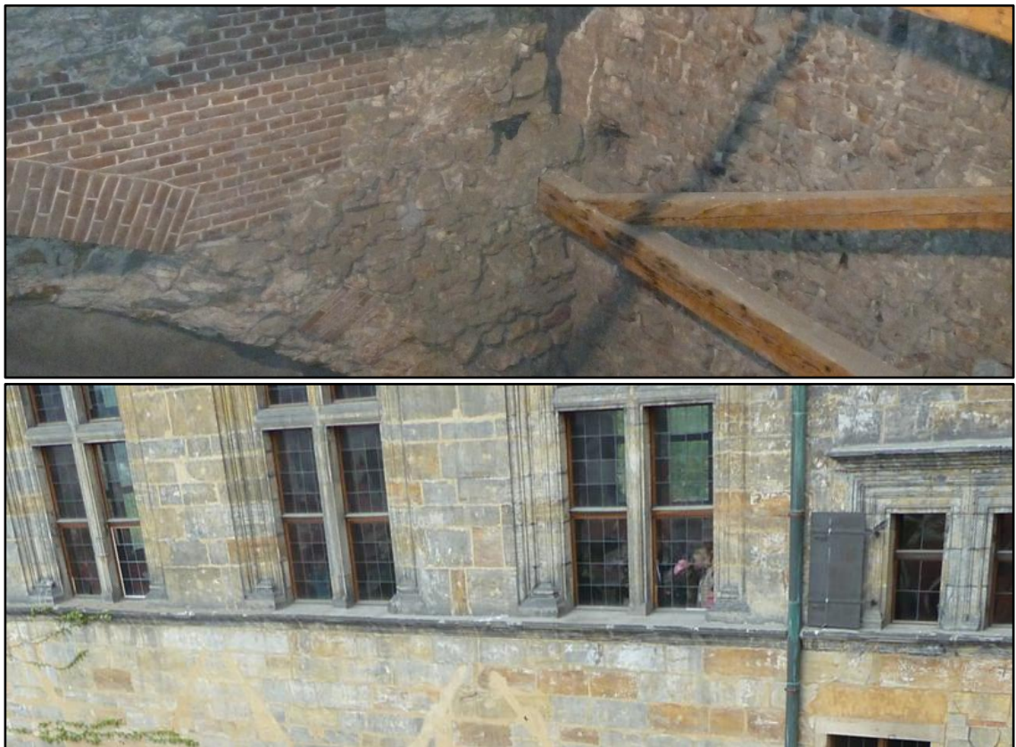
Fig. 26a-26b: muratura disomogenea in pietre irregolari e mattoni nel sottotetto del corpo centrale (sopra) e in blocchi di pietra squadrata per l'Ala di Ludwig (sotto)
