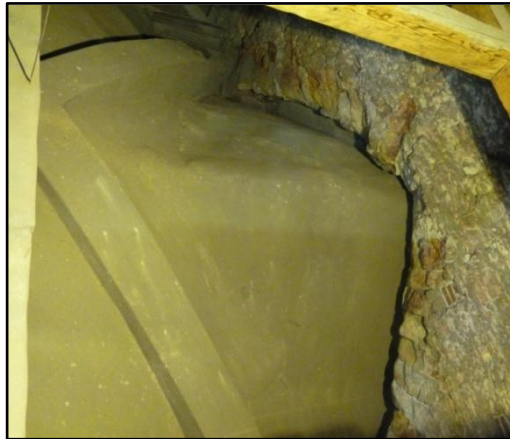
Fig. 56: estradosso della volta con gli archi diagonali
