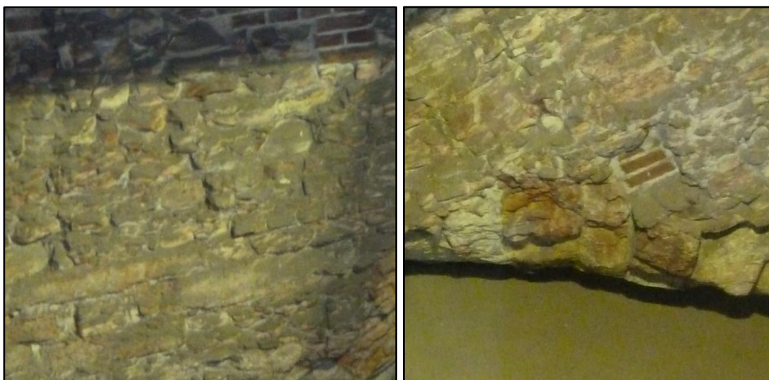
Fig. 13a-13b: dettaglio della muratura irregolare in pietra sbozzata con inclusioni in mattone e dell'arco a sesto acuto disconnesso dalla volta, sottotetto della Sala di Ladislao
