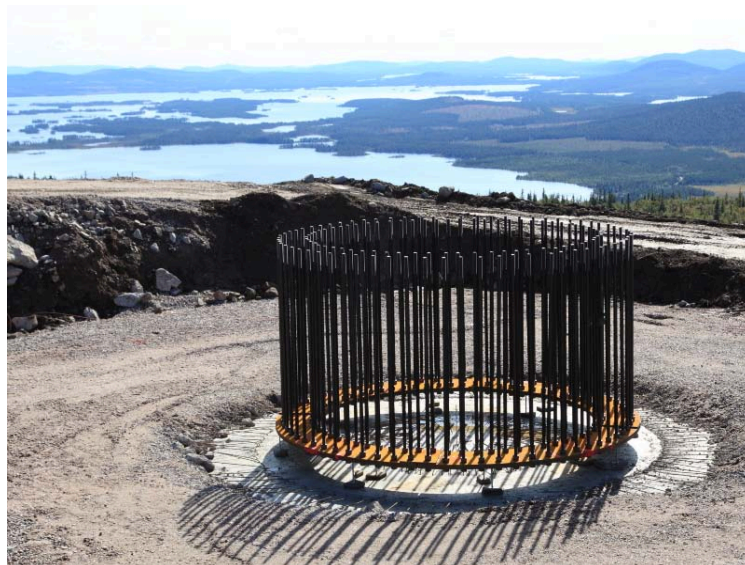
Fig 1.16 – Fondazione a gabbia di tirafondo
